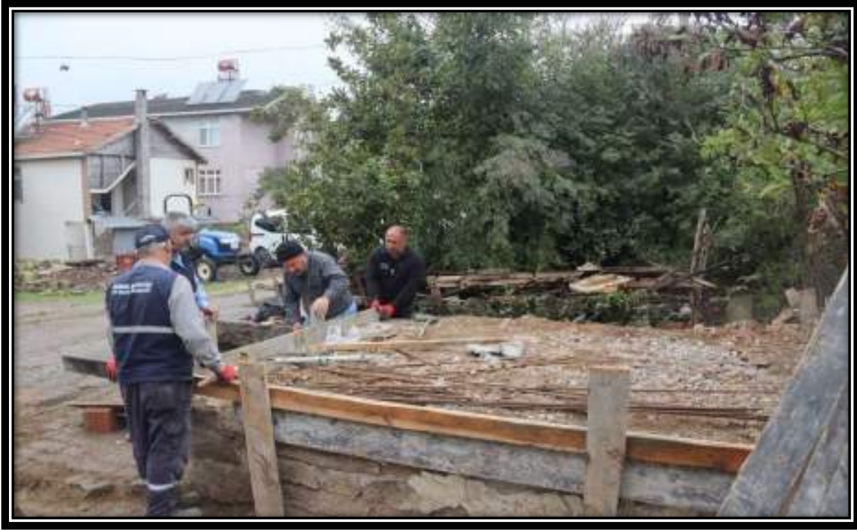
İLÇE GENELİ FIRIN İMALAT ÇALIŞMASI
