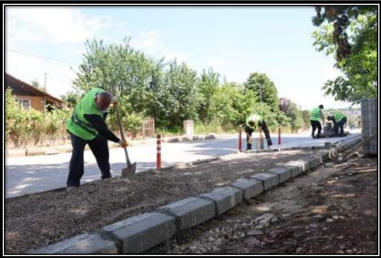
İLÇE MERKEZİ KALDIRIM İMALAT ÇALIŞMASI
