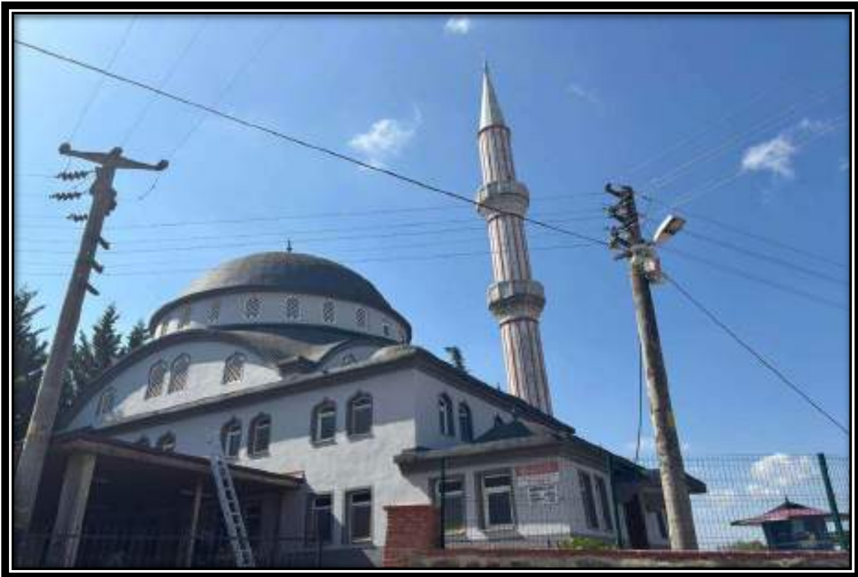
MANCARLAR MAHALLESİ CAMİİ DİŞ CEPHE BOYAMA ÇALIŞMASI
