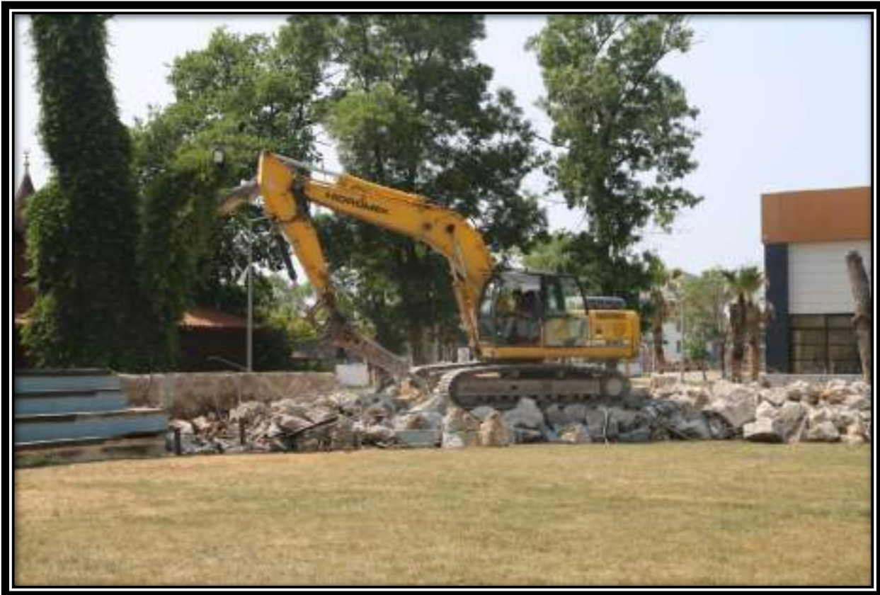
ORHAN MAHALLESİ NAMAZGAH EKSKAVATÖR ÇALIŞMASI
