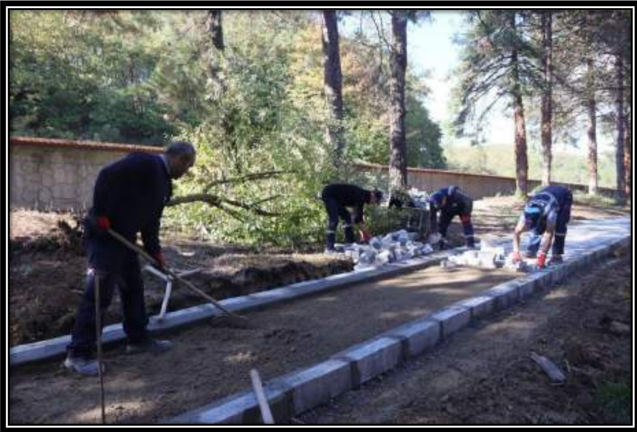
AĞAÇAĞIL MAHALLESİ DERELİ MEVKİİ PARKE İMALAT ÇALIŞMASI
