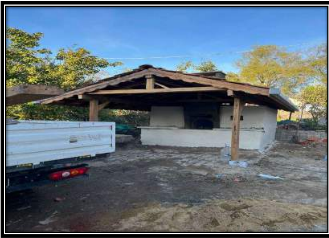
AKÇAOVA MAHALLESİ FIRIN İMALAT ÇALIŞMASI
