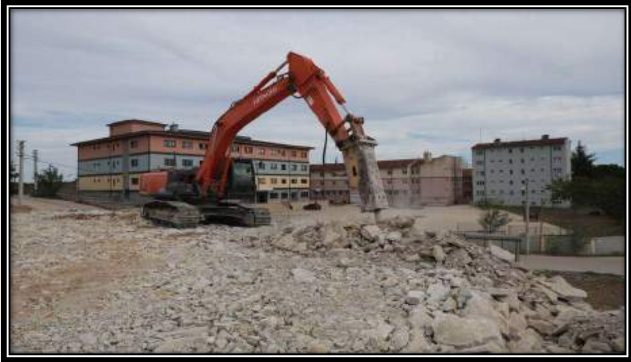
ÇALKÖY MAHALLESİ EKSKAVATÖR ÇALIŞMASI
