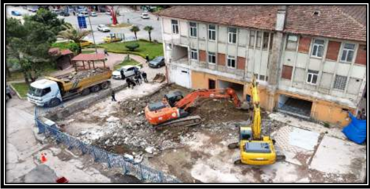
AKDURAK MAHALLESİ ESKİ BELEDİYE BİNASI YIKIM ÇALIŞMASI
