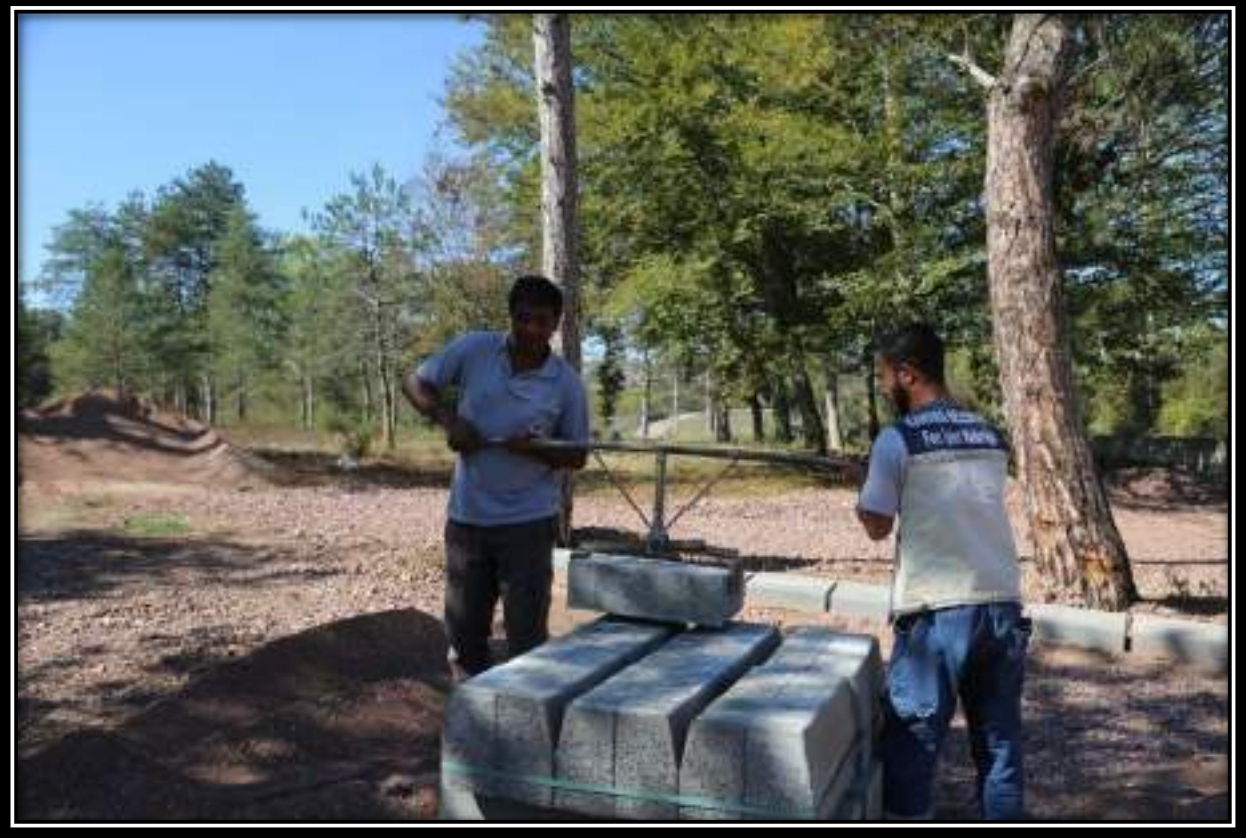
DELİVELİ MAHALLESİ PARKE İMALAT ÇALIŞMASI
