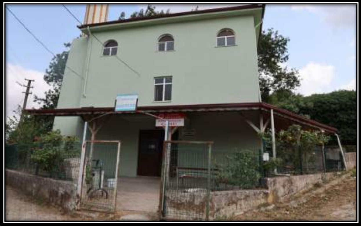
ÜĞÜMCE MAHALLESİ CAMİİ DIŞ CEPHE BOYAMA ÇALIŞMASI
