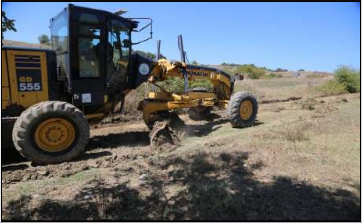
Arazi Yolu Tesviye Çalışması (Reglaj)
