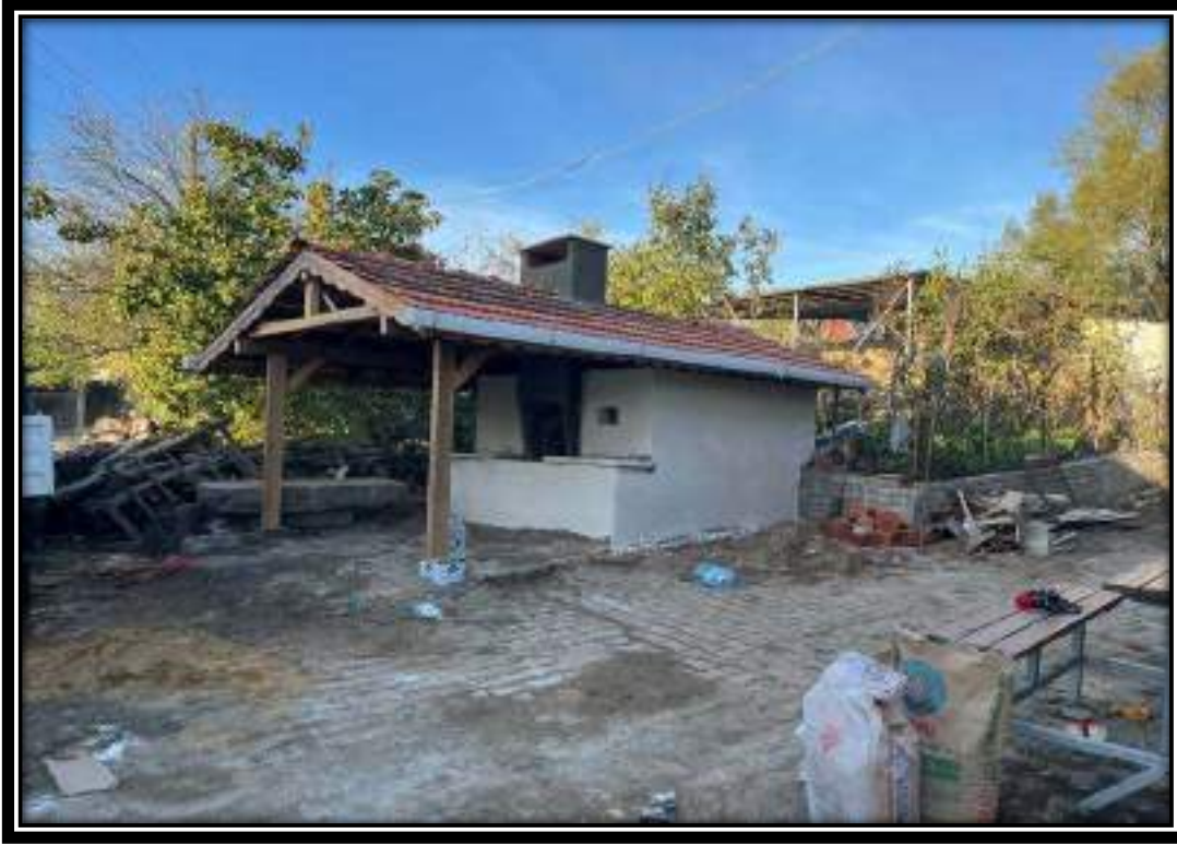
ANTAPLI MAHALLESİ FIRIN İMALAT ÇALIŞMASI
