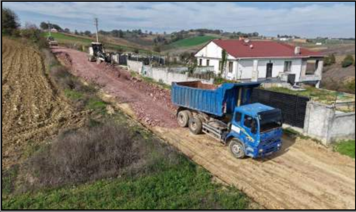
Elmacık Mahallesi Stabilize Serim Çalışması
