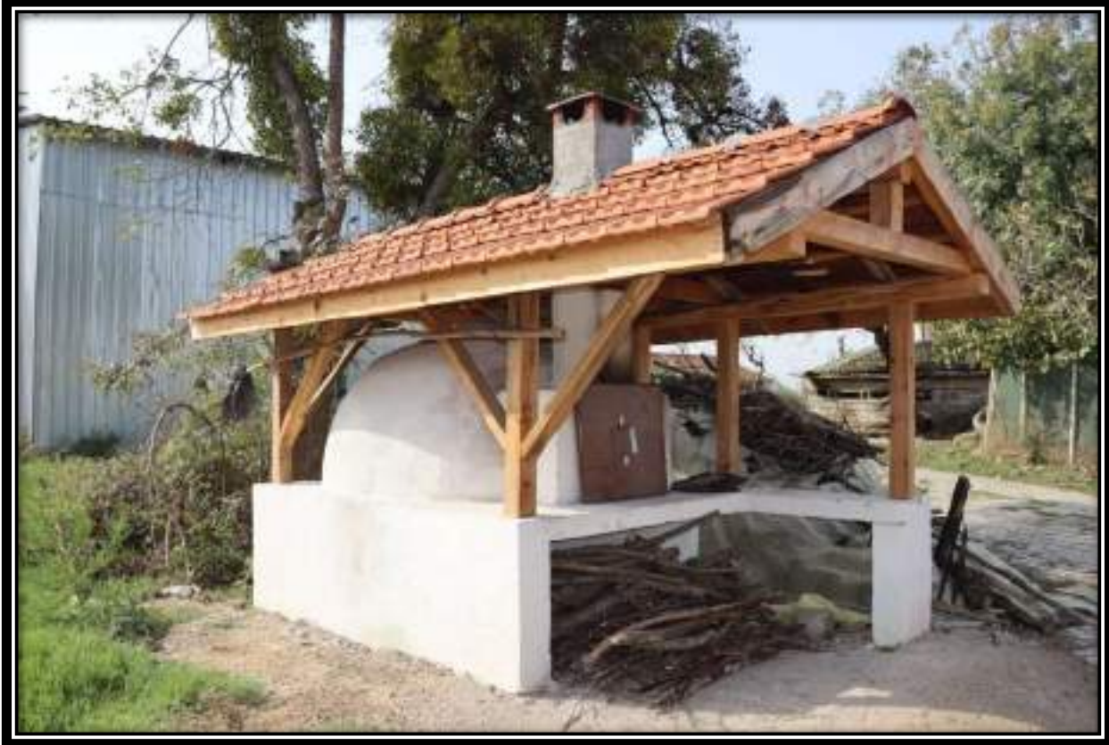
İLÇE GENELİ FIRIN İMALAT ÇALIŞMASI
