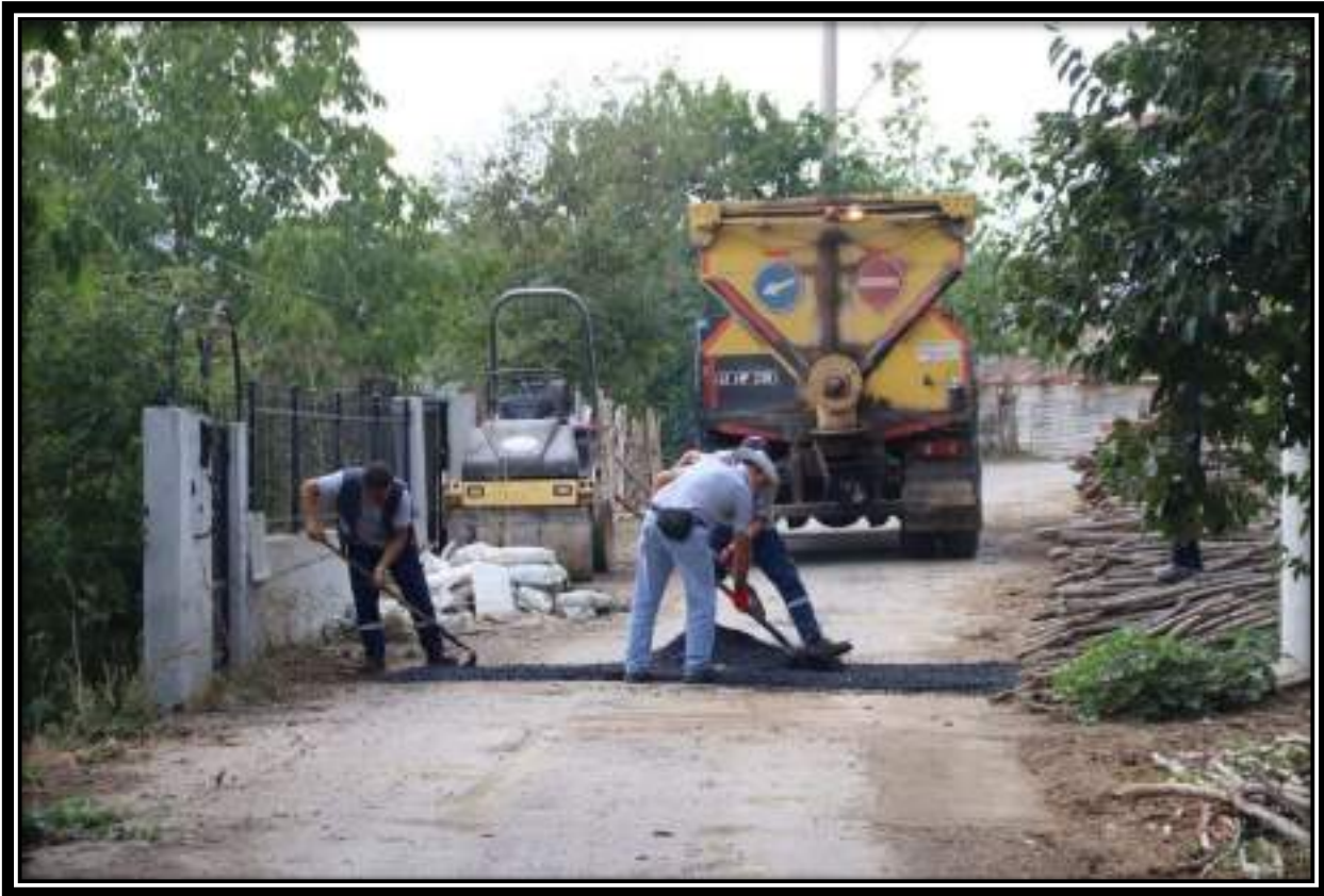
ANTAPLI MAHALLESİ ASFALT YAMA ÇALIŞMASI
