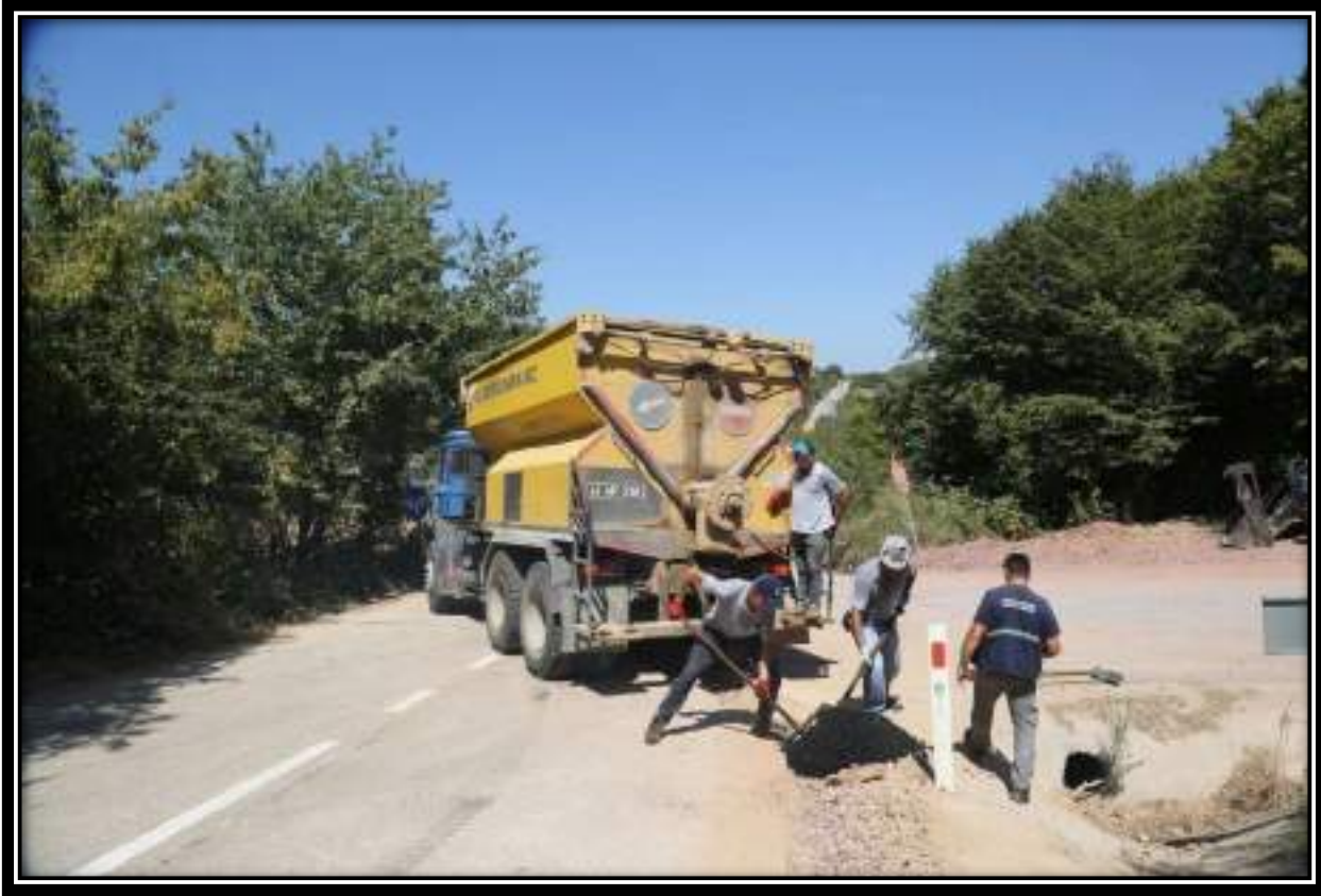
KABAĞAÇ MAHALLESİ ASFALT YAMA ÇALIŞMA
