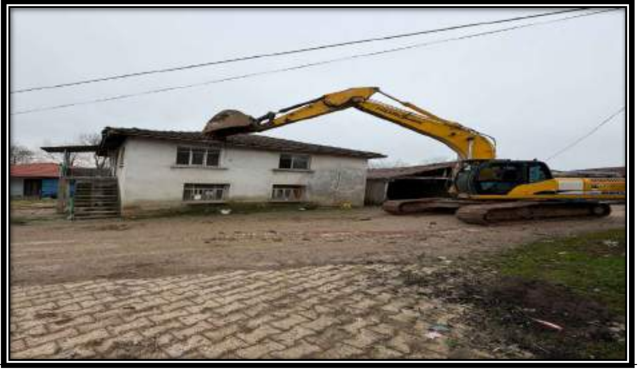
İLÇE GENELİ METRUK BİNA YIKIM ÇALIŞMASI
