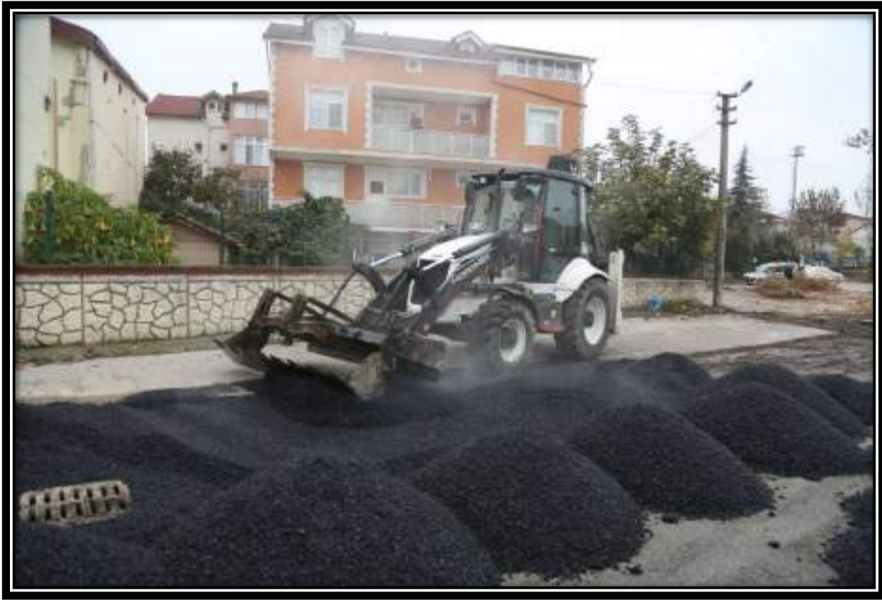
AKDURAK MAHALLESİ ASFALT YAMA ÇALIŞMASI
