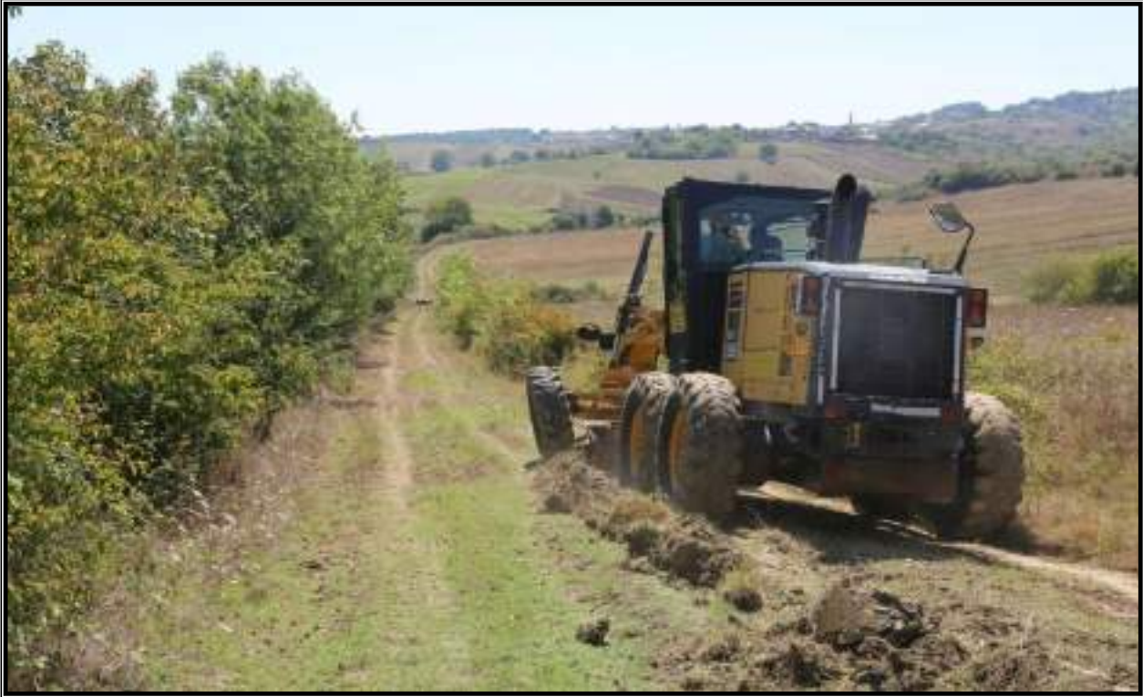
Arazi Yolu Tesviye Çalışması (Reglaj)
