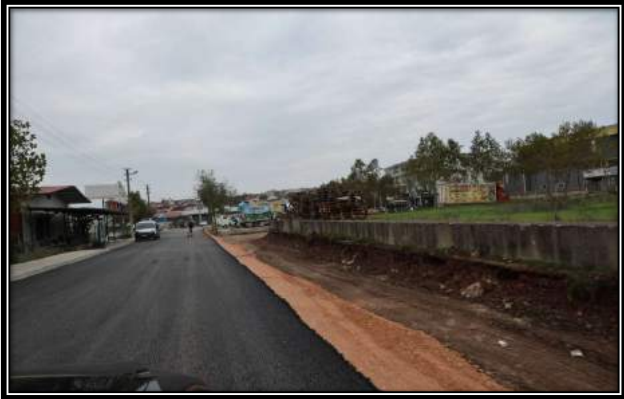
ÇARŞI MAHALLESİ ASFALT YAMA ÇALIŞMASI
