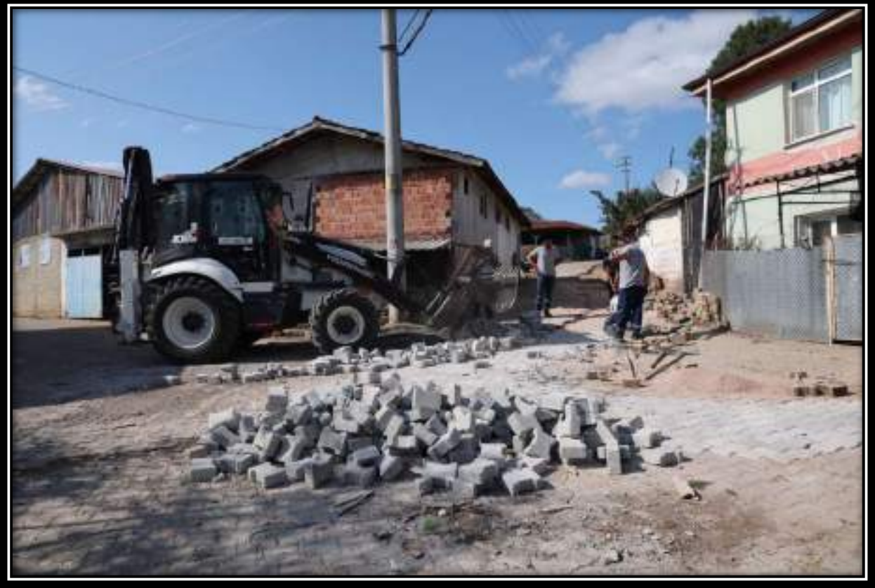
AKBAL MAHALLESİ PARKE YAMA ÇALIŞMASI
