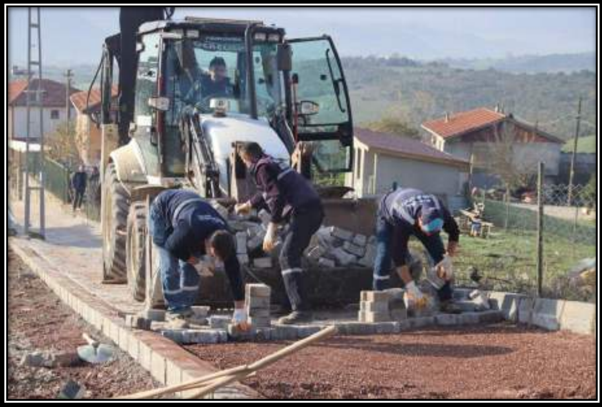
İLÇE MERKEZİ KALDIRIM İMALAT ÇALIŞMASI
