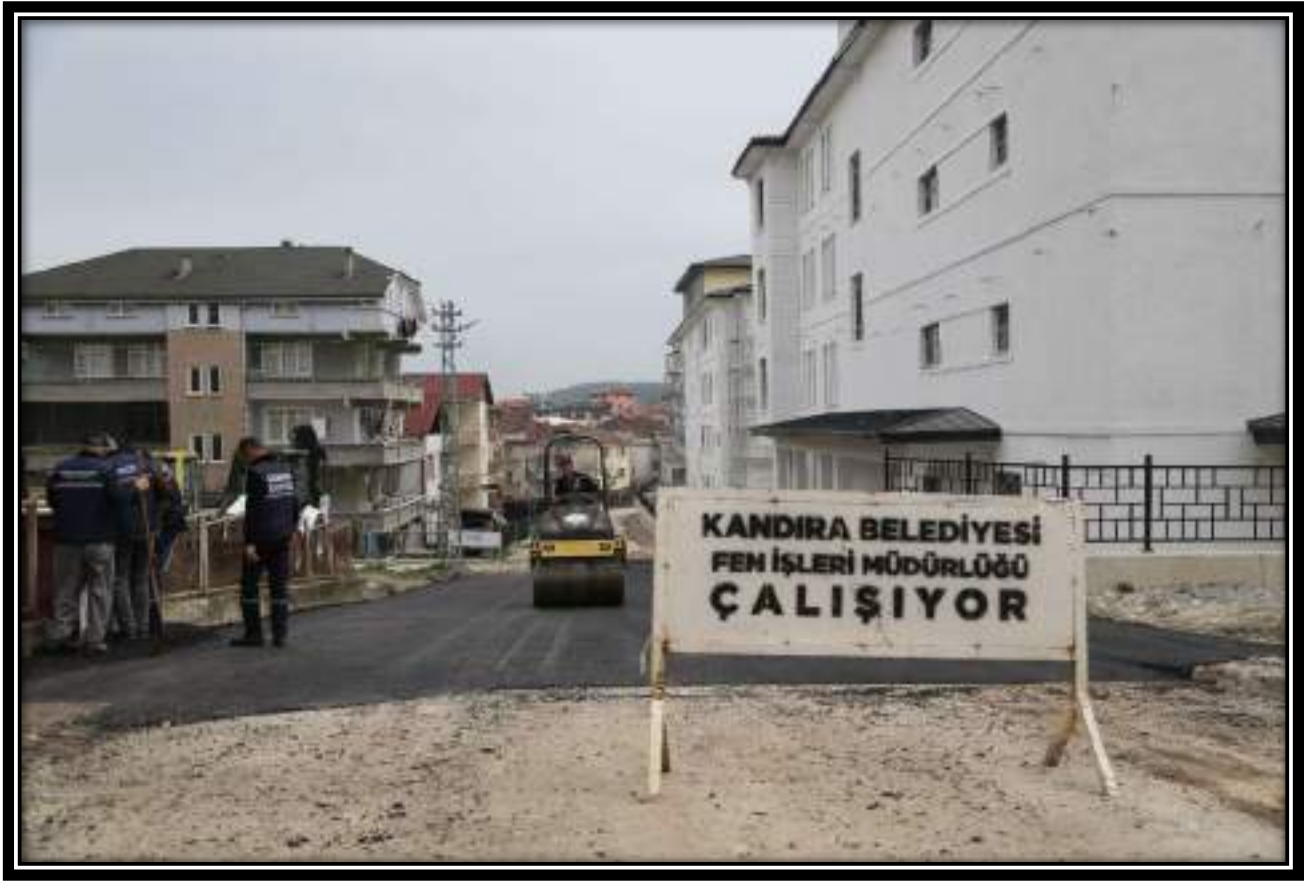
AYDINLIK MAHALLESİ ASFALT YAMA ÇALIŞMASI
