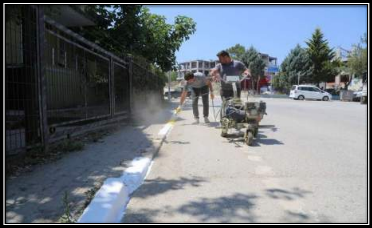
İLÇE MERKEZİ BORDÜR BOYAMA ÇALIŞMASI
