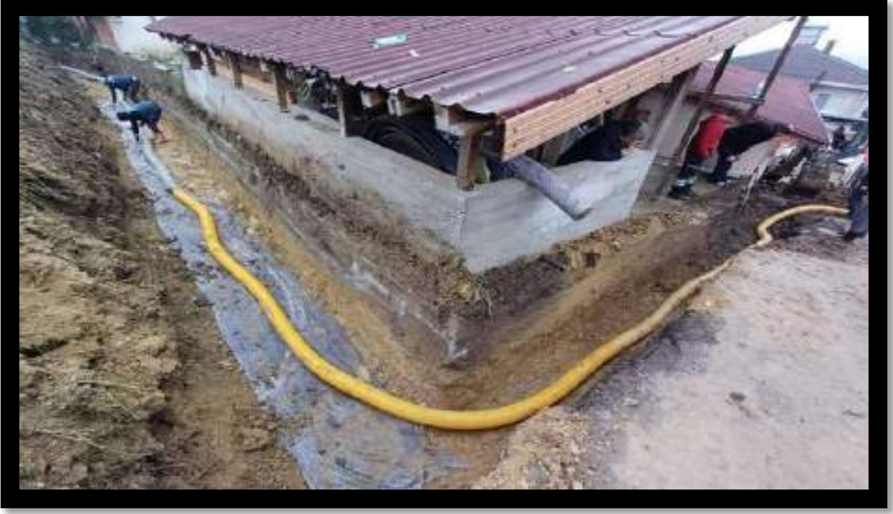
Eğercili Mahallesi Güvenler Mevkii Cami Etrafı Drenaj Çalışması
