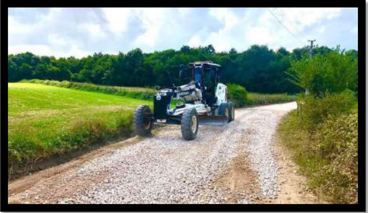
Kefken Mahallesi Arazi Yolu Tesviye Çalışması
