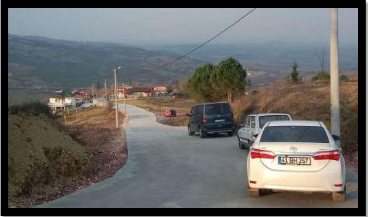
Pirceler Mahallesi Beton Yol İmalat Çalışması
