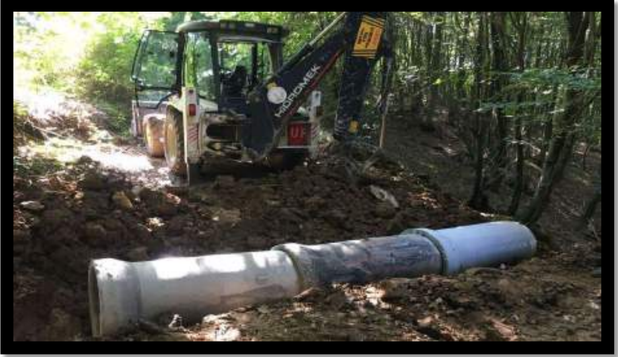
Kzılcapınar Mahallesi Büz Koyma Çalışması
