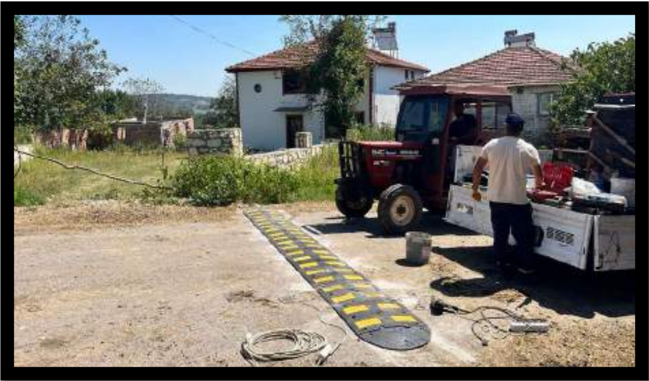
Eğercili Mahallesi Güvenler Mevkii Kasis Montaj Çalışması
