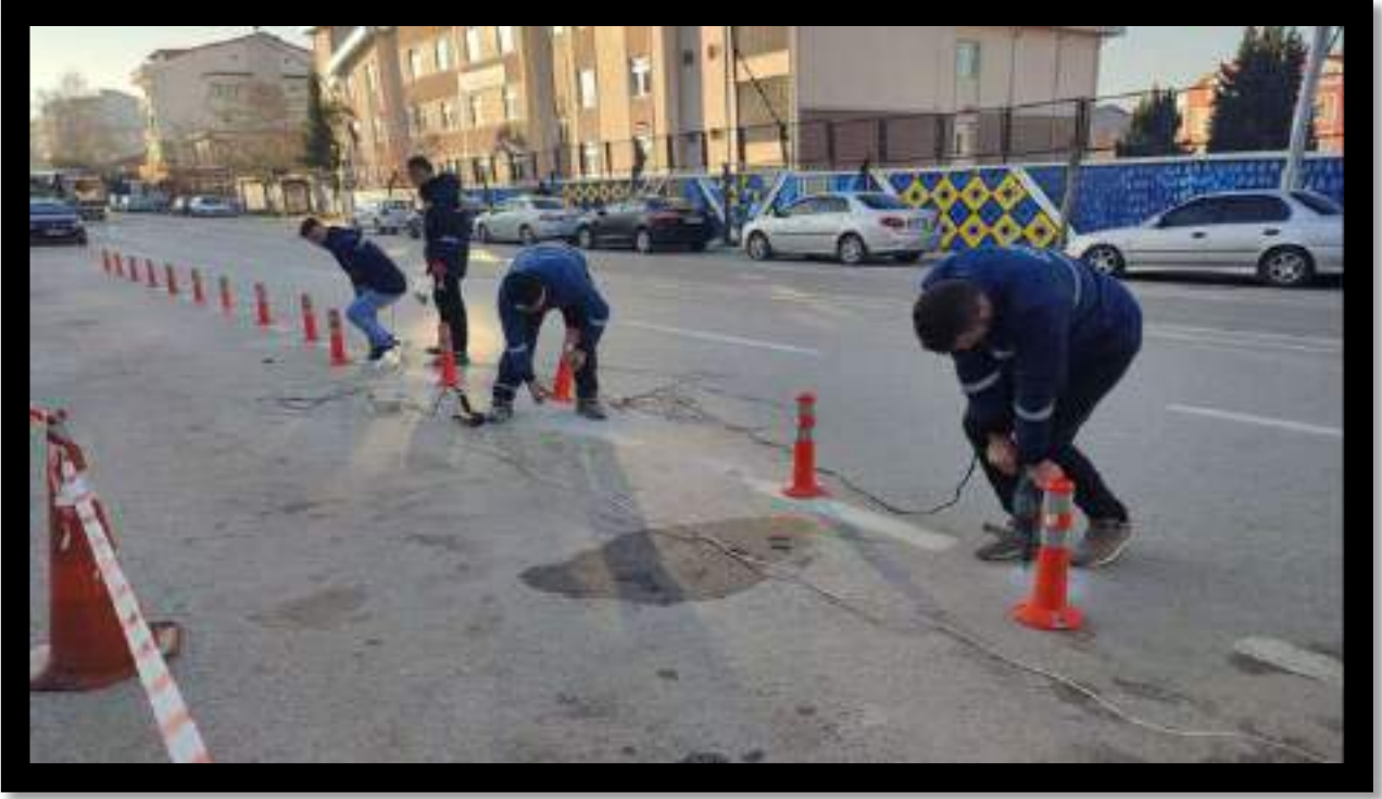
Çarşı Mahallesi Delinatör Montaj Çalışması
