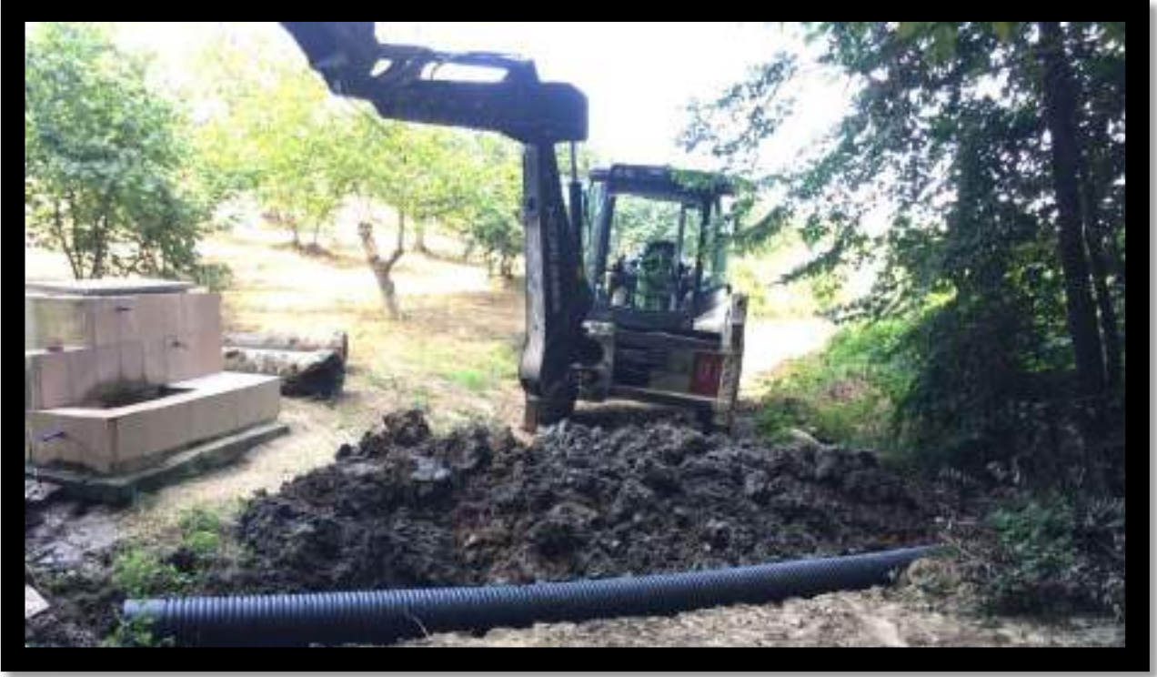
Pelitpınarı Mahallesi Koruge Boru Koyma Çalışması
