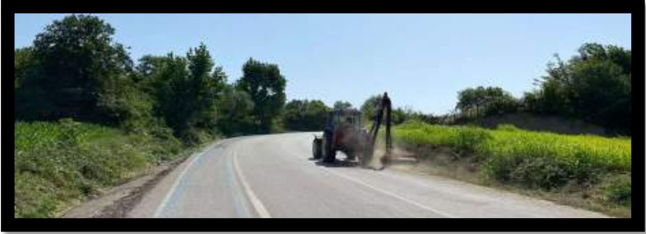
Carşı Mahallesi Eski İzmit Yolu Çalı Canavarı Çalışması
