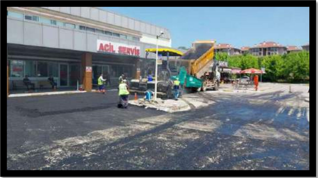
Kandıra Devlet Hastanesi Önü Asfalt İmalat Çalışması
