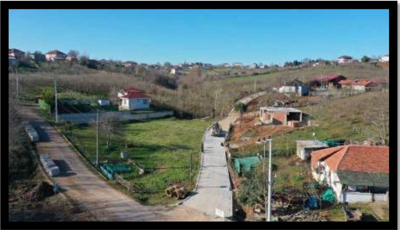
Karaağaç Mahallesi Parke İmalat Çalışması
