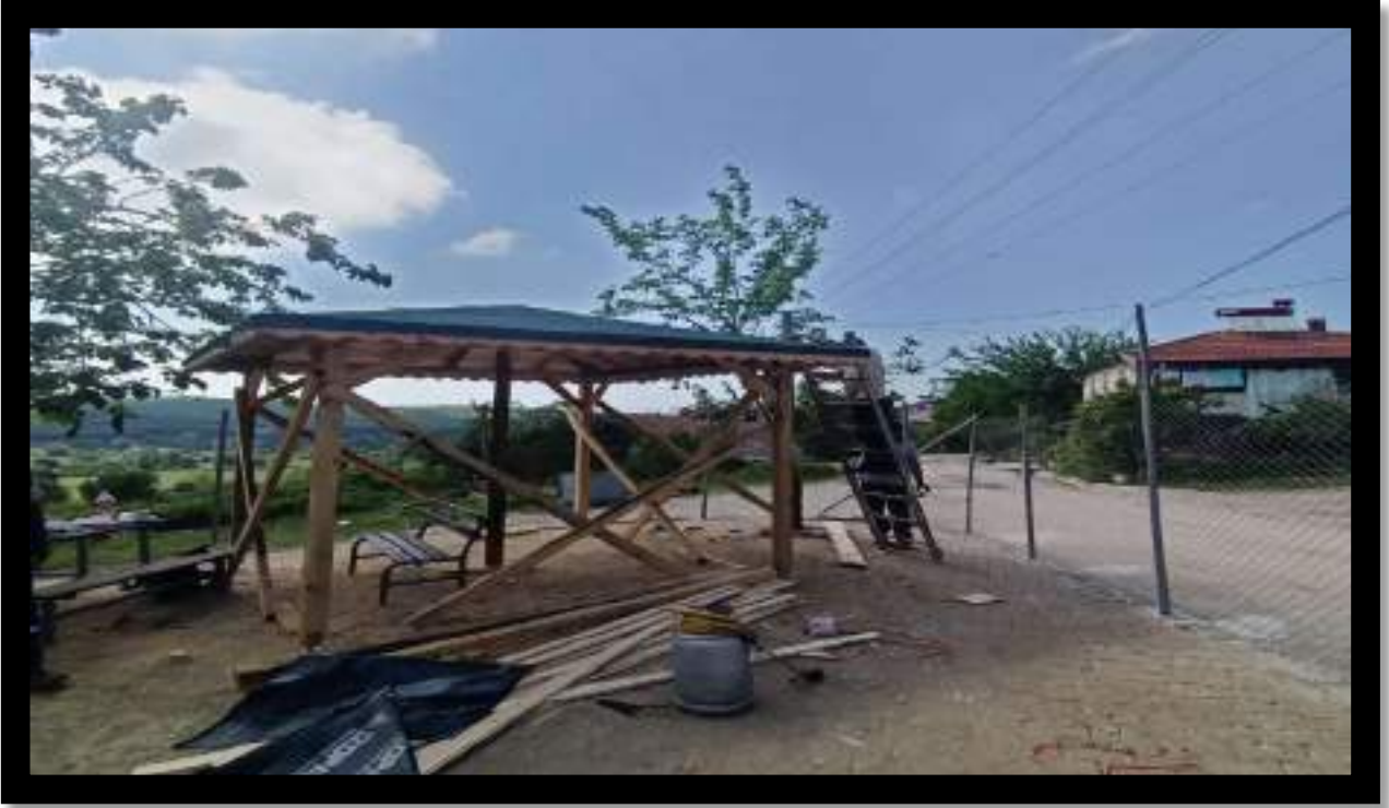
Ballar Mahallesi Rıdvanlar Mevkii Kamelya İmalat Çalışması
