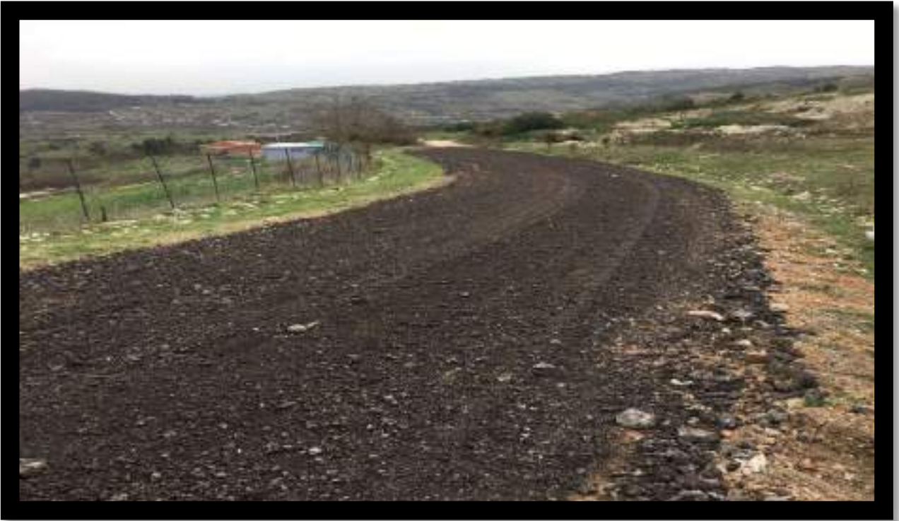
Selametli Mahallesi Malzeme Serim Çalışması
