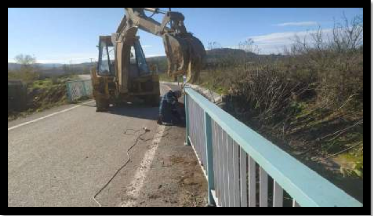
Akıncı Mahallesi Köprü Korkuluk İmalat Çalışması
