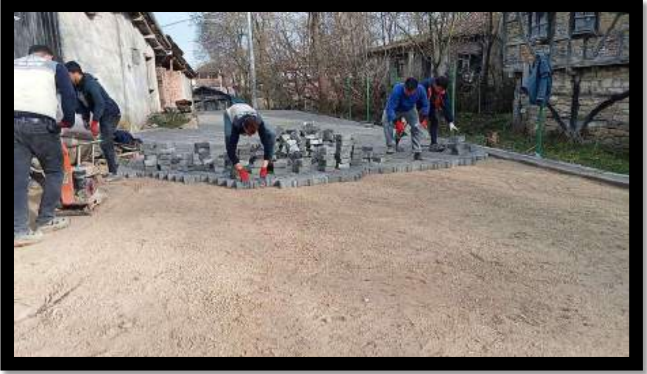
Topluca Mahallesi Parke İmalat Çalışması
