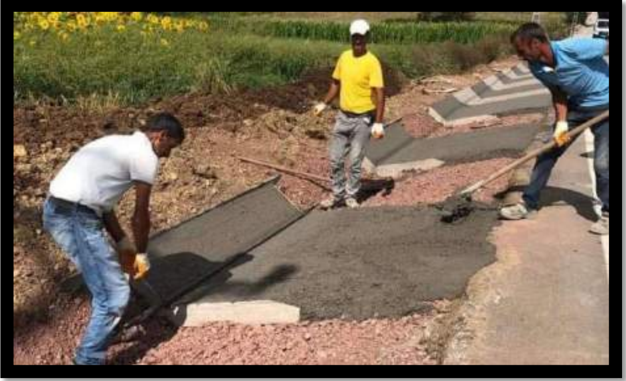
Kırkarmut Mahallesi V Kanal İmalat Çalışması
