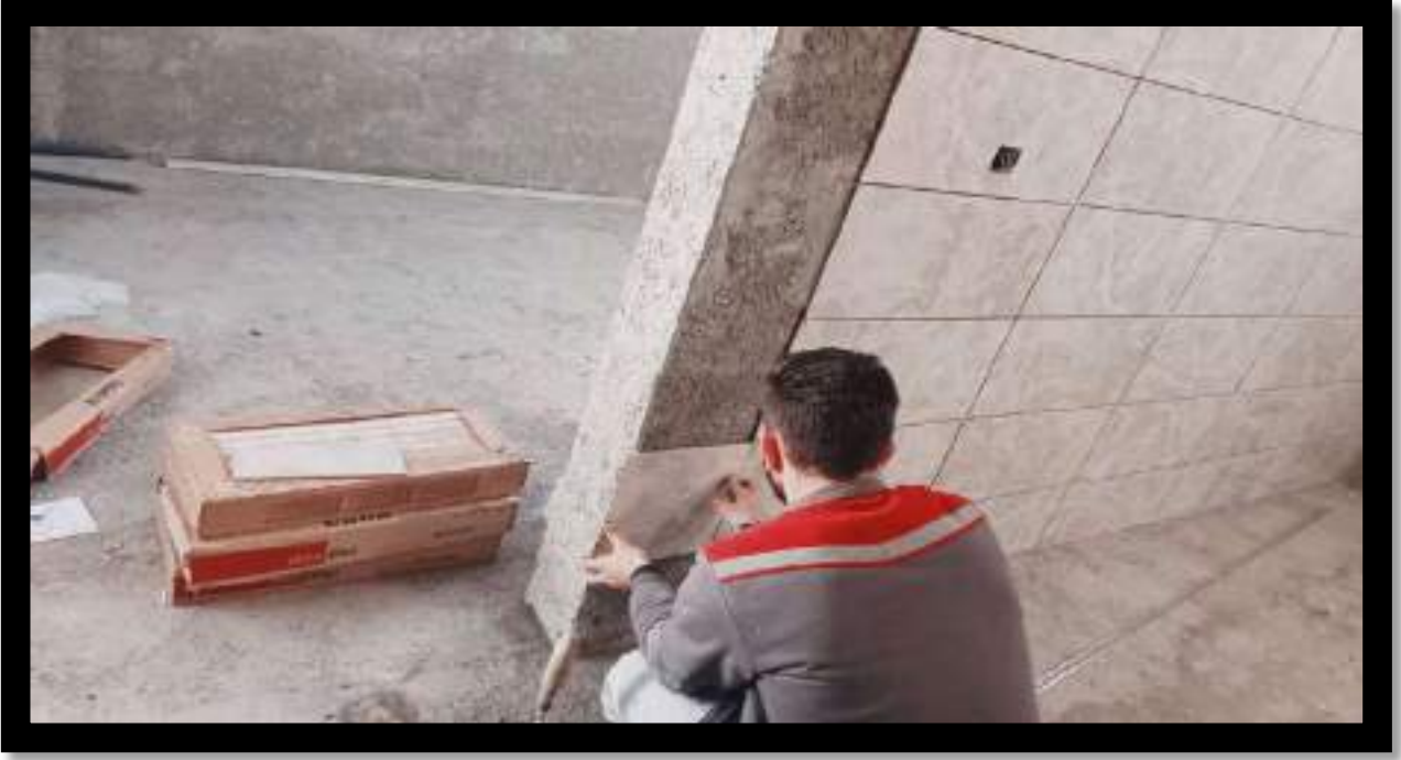
Orhan Mahallesi Asri Mezarlık Gasilhane Seramik Çalışması
