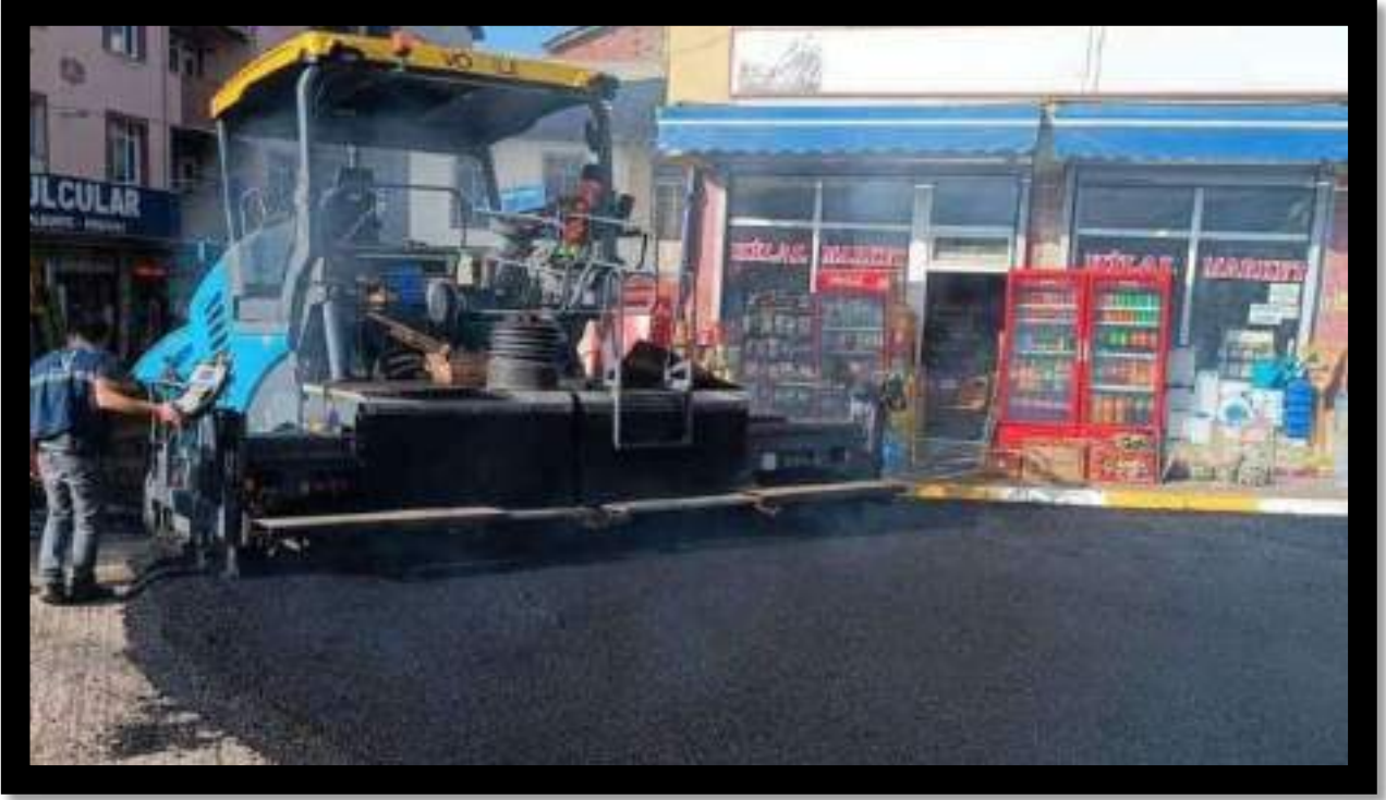
İlçe Merkezi Asfalt Yol İmalat Çalışması
