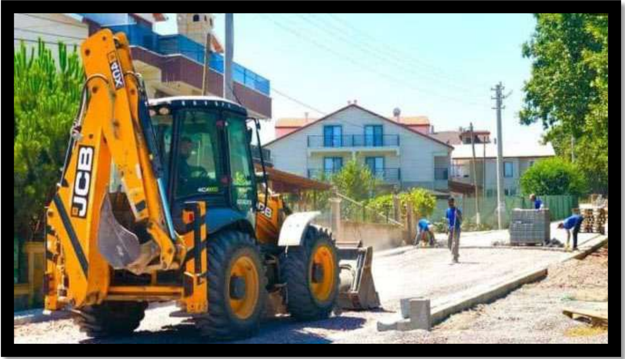
Cebeci Mahallesi Parke İmalat Çalışması
