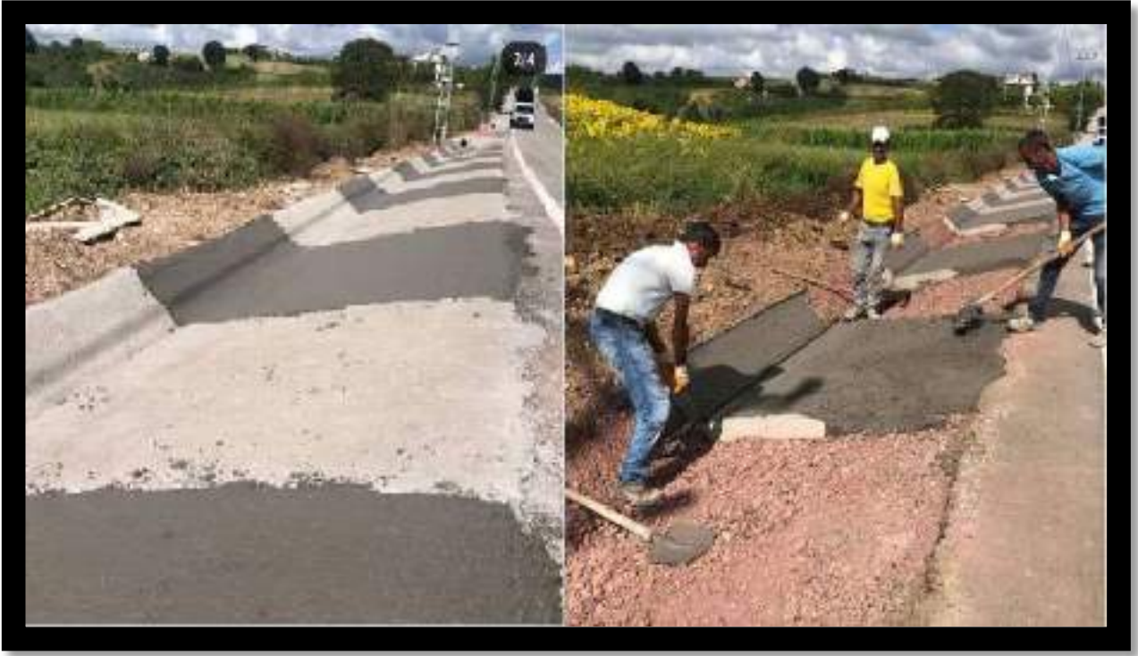
Kırkarmut Mahallesi V Kanal İmalat Çalışması
