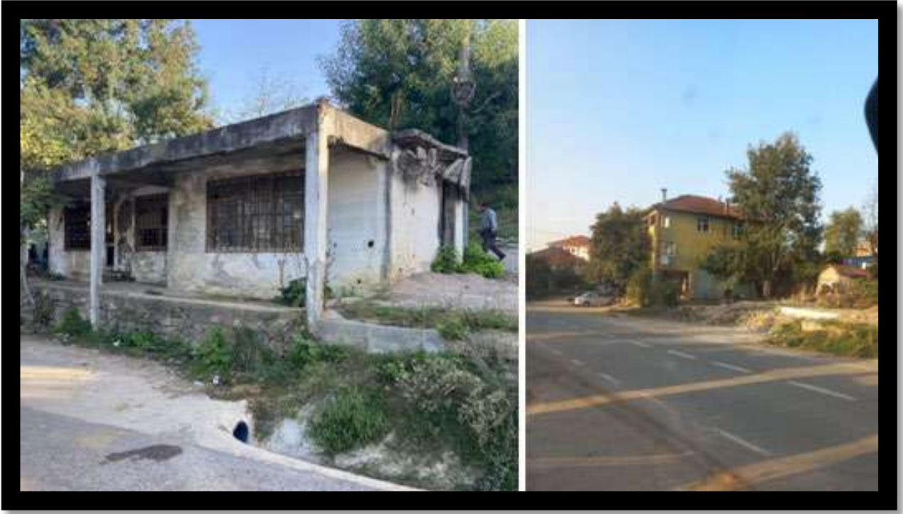
Kaymaz Araman Mahallesi Metruk Bina Yıkım Çalışması
