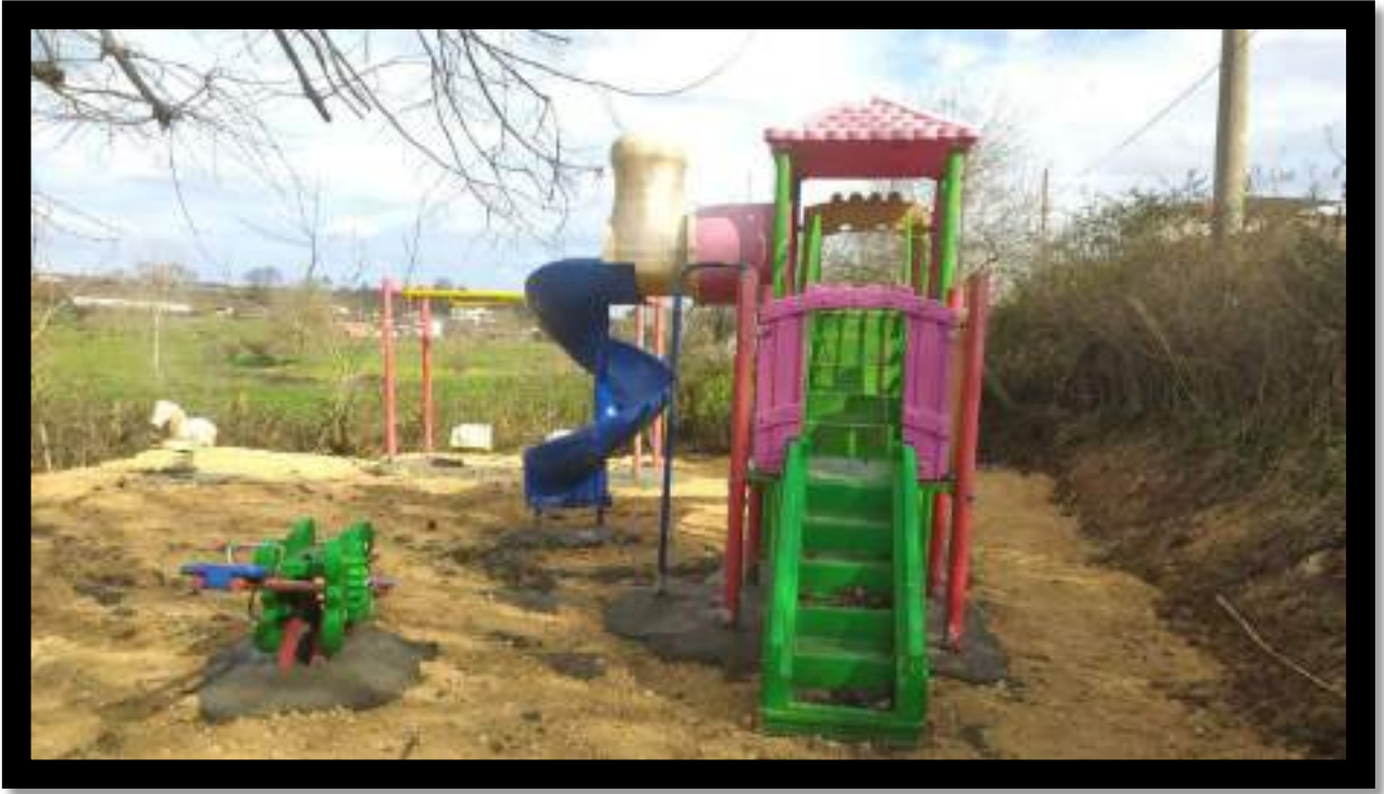
Duraklı Mahallesi Oyun Grubu Montaj Çalışması
