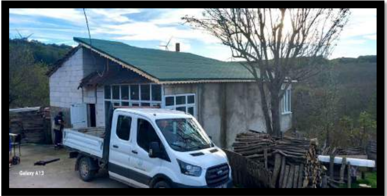
Karaağaç Mahallesi Merkez Mevkii Gariban Evi Çatı İmalat Çalışması
