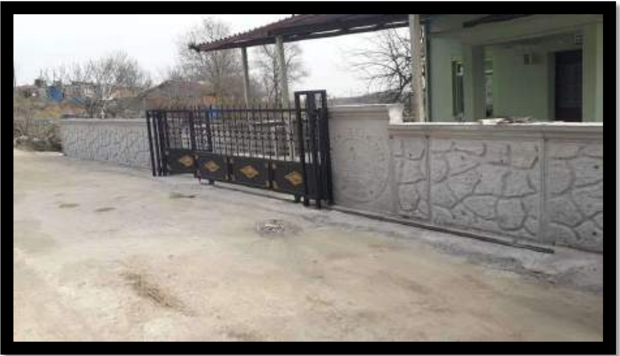
Selimköy Mahallesi Çavuşlar Camii Beton Duvar İmalat Çalışması
