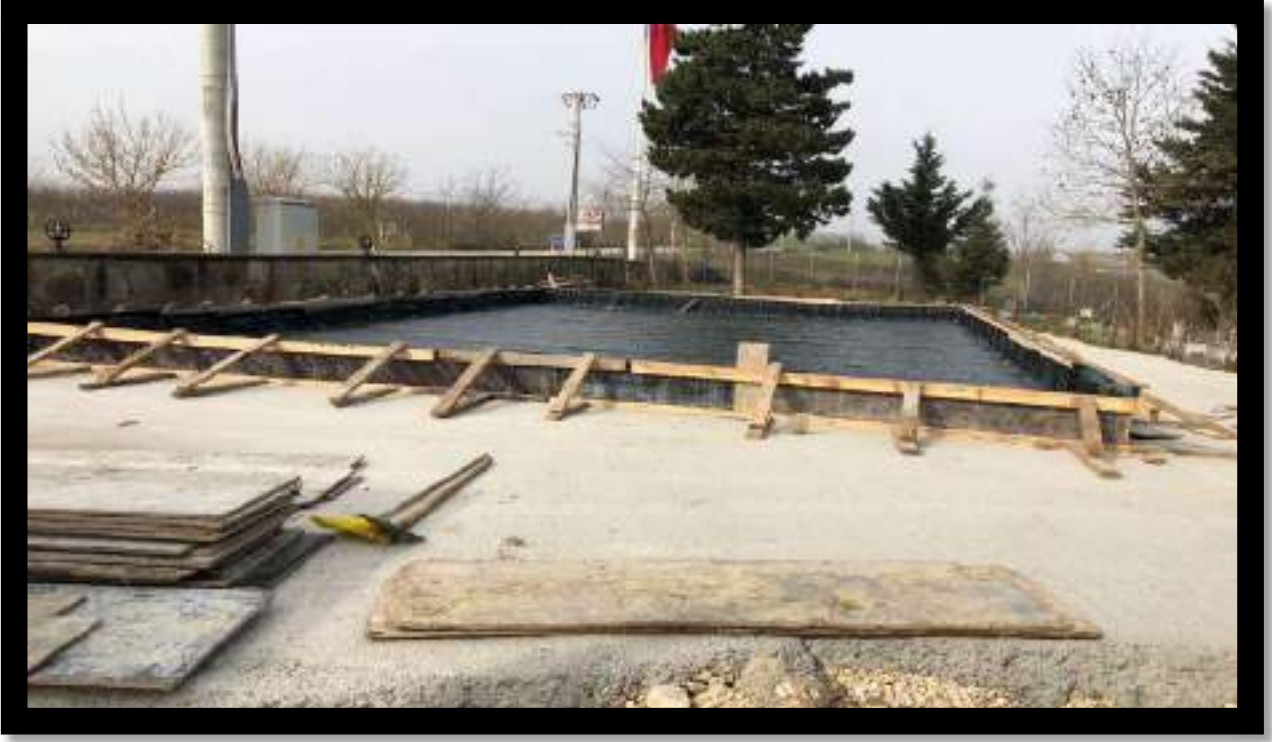
Orhan Mahallesi Asri Mezarlık Gasilhane Temel Atma Çalışması
