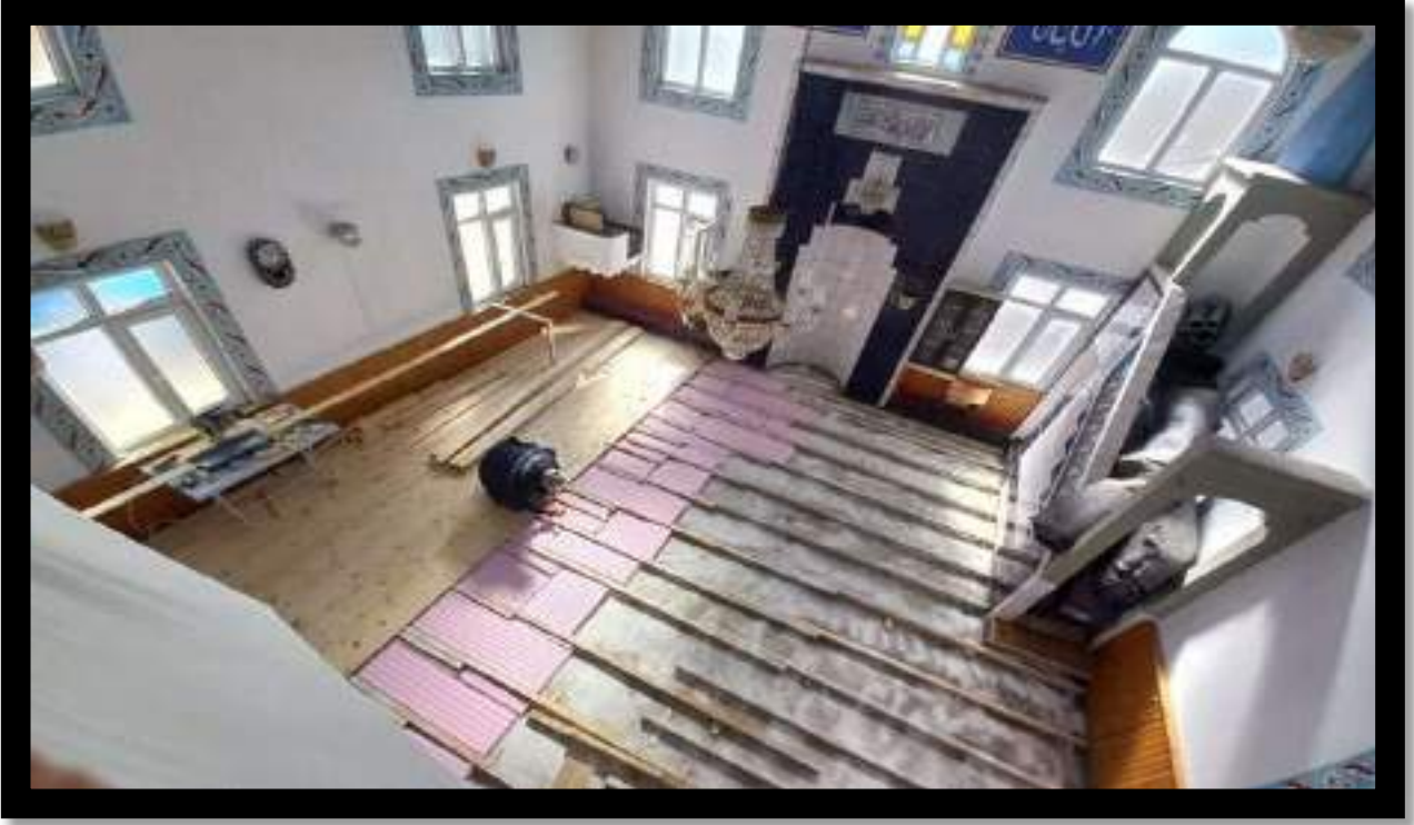
Karadivan Mahallesi Davutlar Camii Döşeme Tahtası İmalat Çalışması
