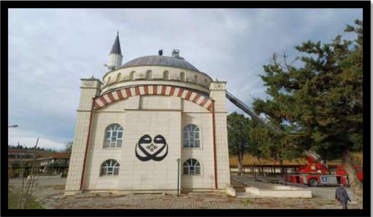
Orhan Mahallesi Toki Camii Kubbe Bakım ve Onarım Çalışması
