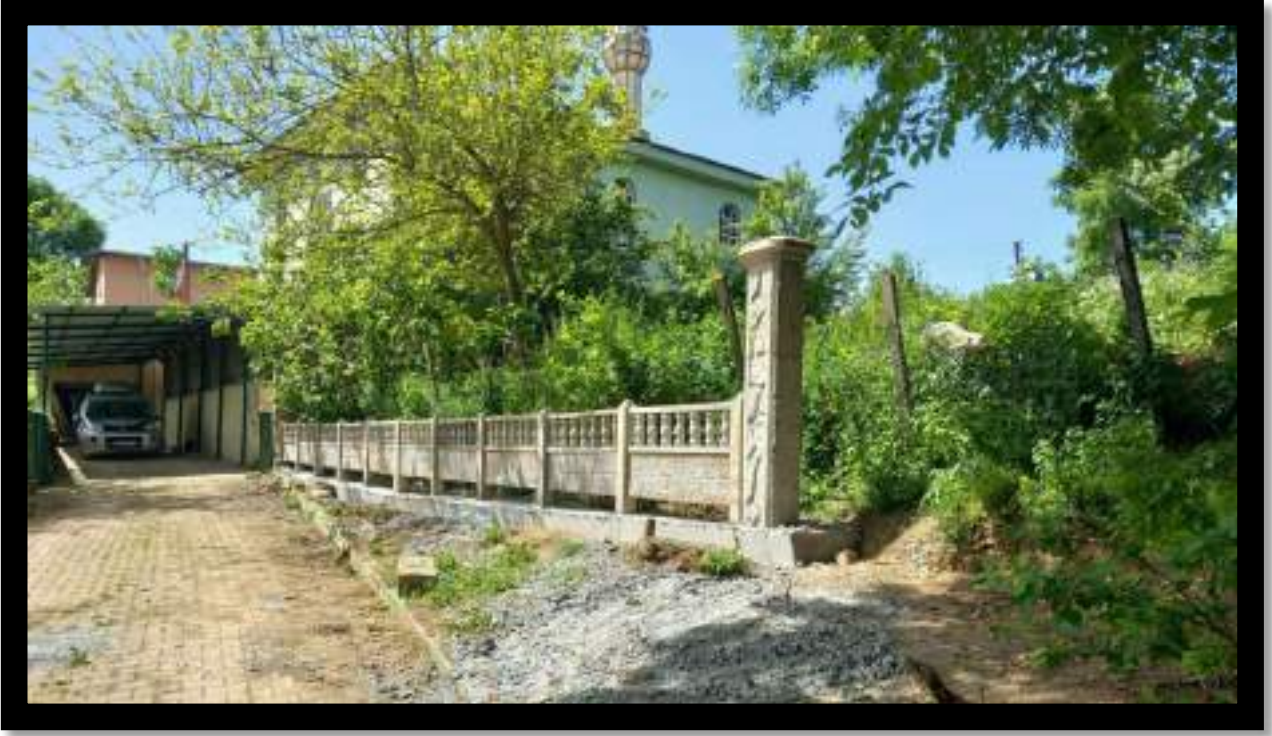
Sevitaliler Mahallesi Beton Panel Çalışması
