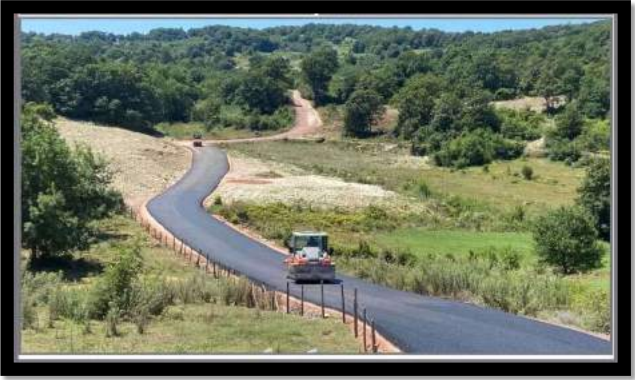
Akıncı-Cerçili Mahalleleri Arası Asfalt Yol İmalat Çalışması
