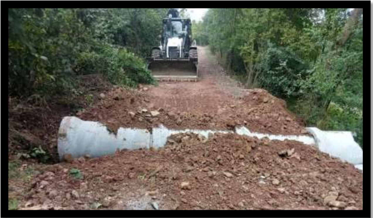
Sinanlı Bilalli Mahallesi Büz Koyma Çalışması
