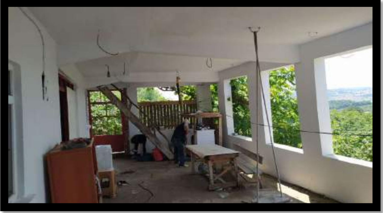
Hacılar Mahallesi Gariban Evi Boyama Çalışması
