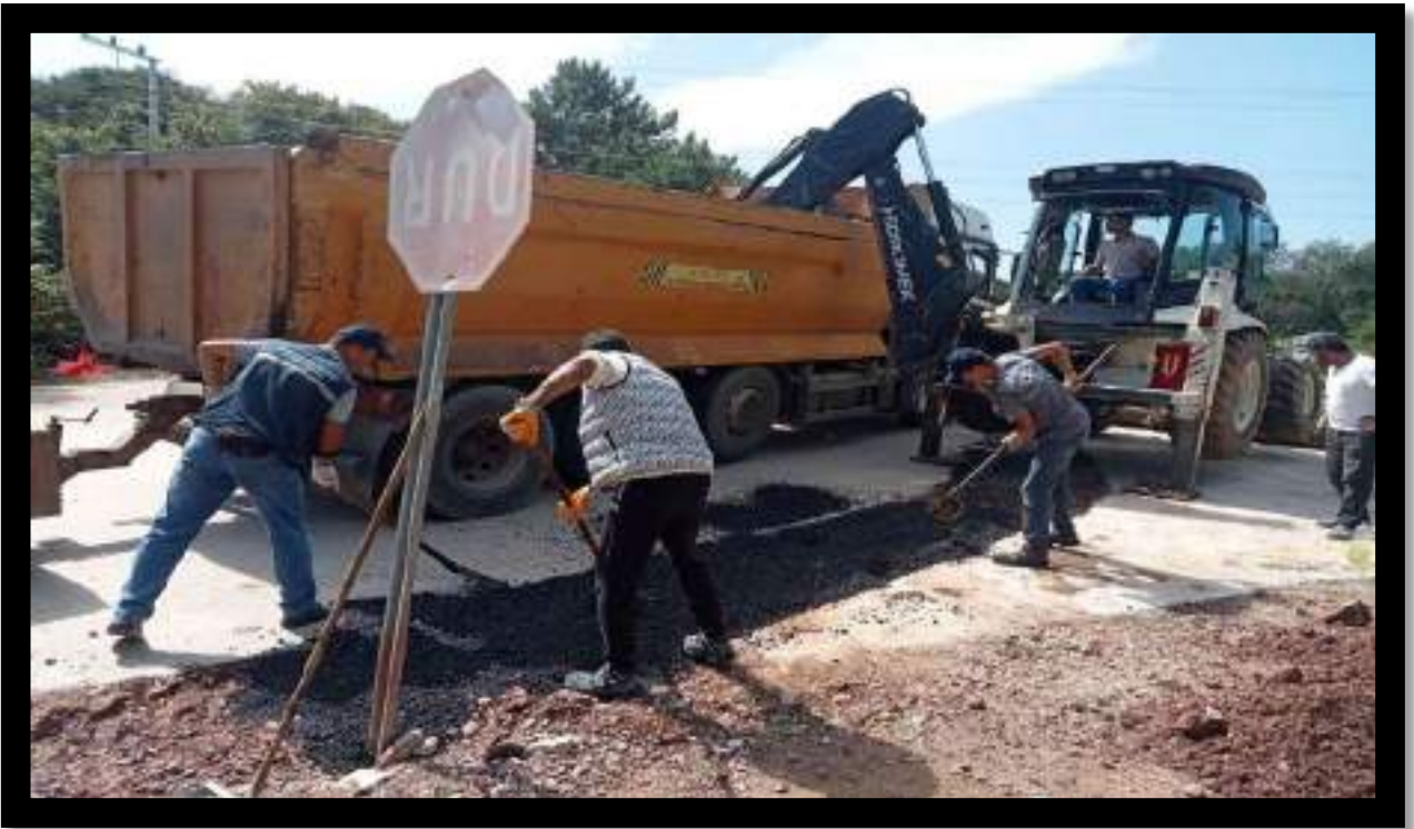
Doğancılı Mahallesi Asfalt Bakım Onarım Çalışması
