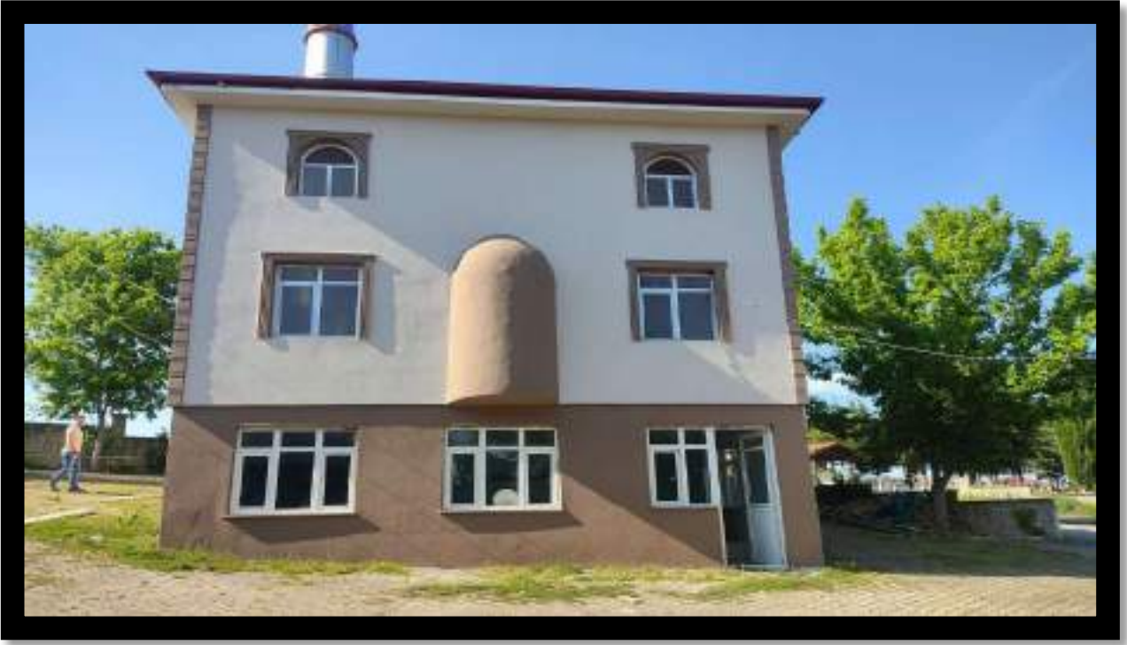
Ballar Mahallesi Merkez Camii Dış Cephe Boyama Çalışması
