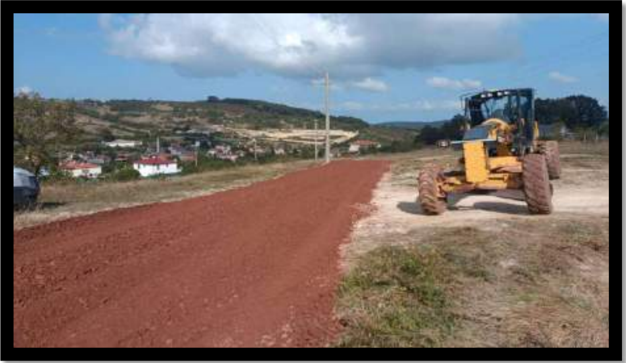
Yağcılar Mahallesi Stabilize İmalat Çalışması
