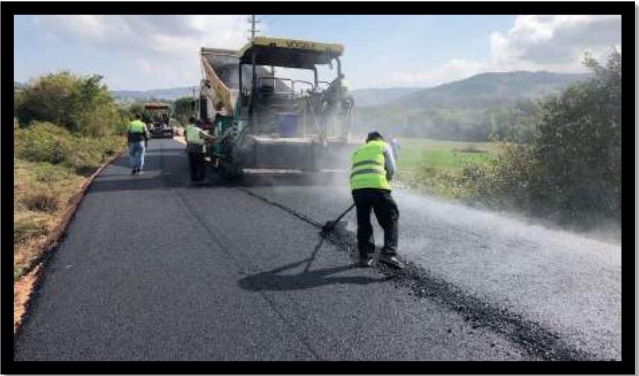
Teksen-Akçaova Mahalleleri Arası Asfalt Yol İmalat Çalışması
