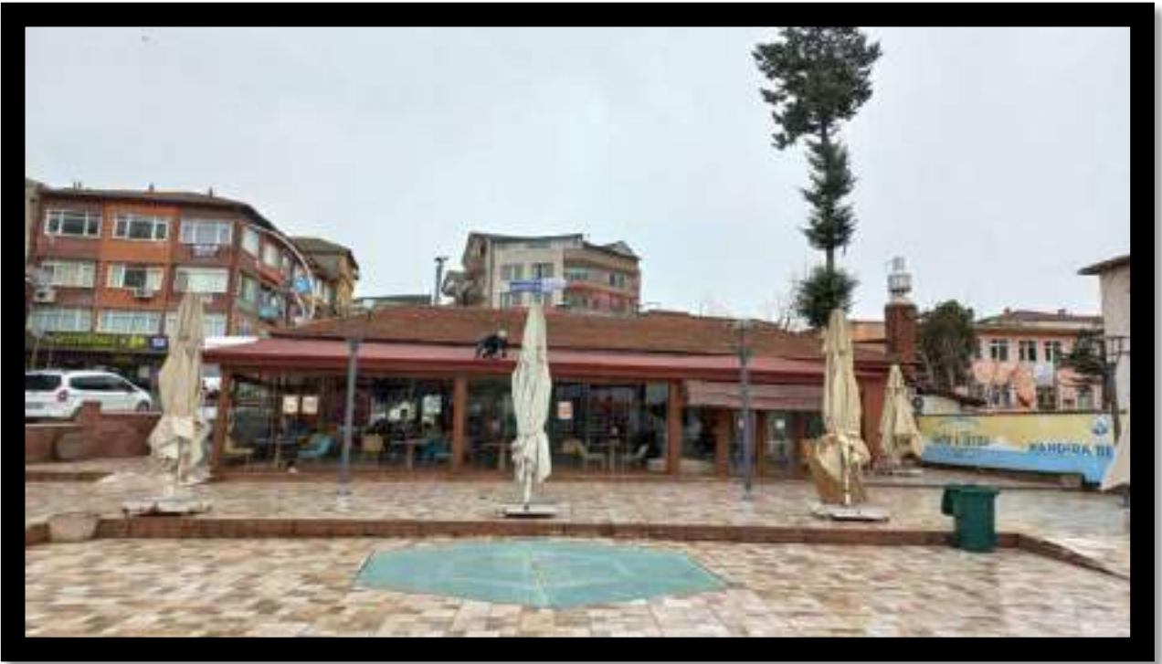
Akdurak Mahallesi Teras Kafe Çatı İmalat Çalışması
