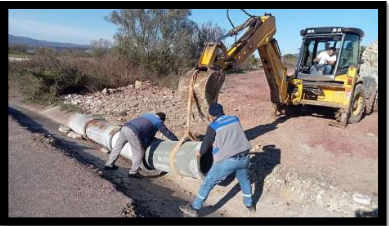
Akçaova Mahallesi Büz Koyma Çalışması
