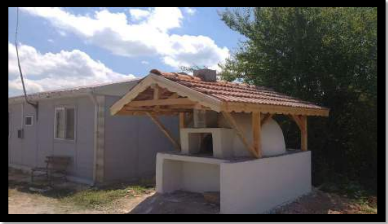
Akcaova Mahallesi Tokaşlar Mevkii Fırın İmalat Çalışması
