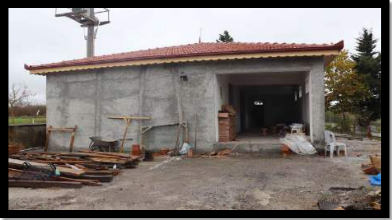
Orhan Mahallesi Asri Mezarlık Gasilhane Sıva Çalışması
