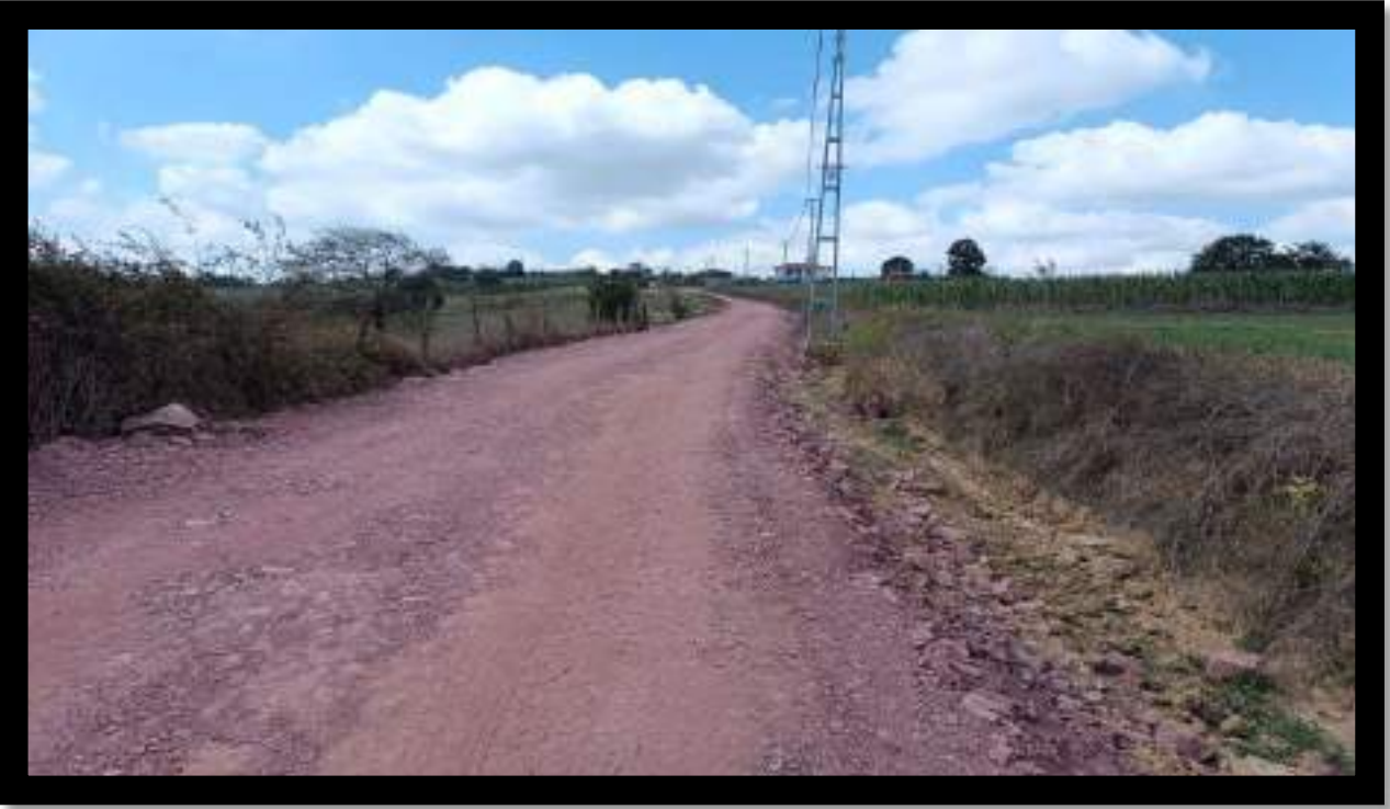
Sarıcaali Mahallesi Stabilize Serim ve Bakım Çalışması
