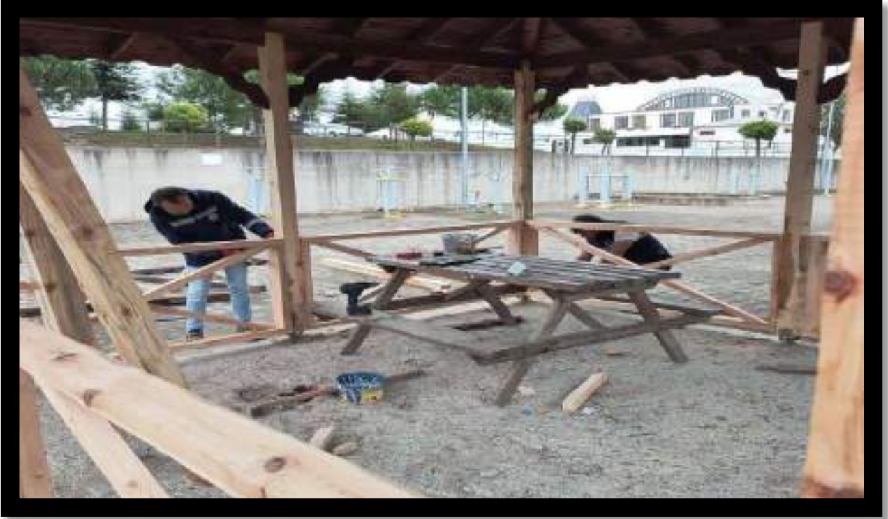
Kocakaymas Mahallesi Cezaevi Lojmanı Kamelya Bakım Onarım
