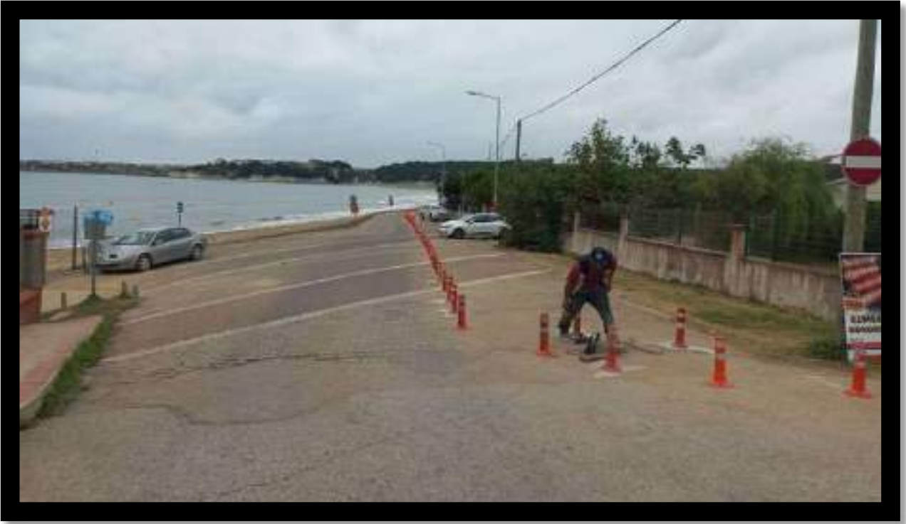
Kurtyeri Mahallesi Kumcağz Mevkii Delinatör Montaj Çalışması
