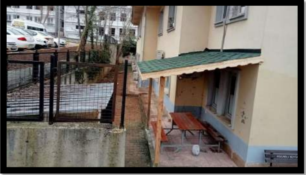
Akdurak Mahallesi İlçe Sağlık Ocağı Sundurma İmalat Çalışması
