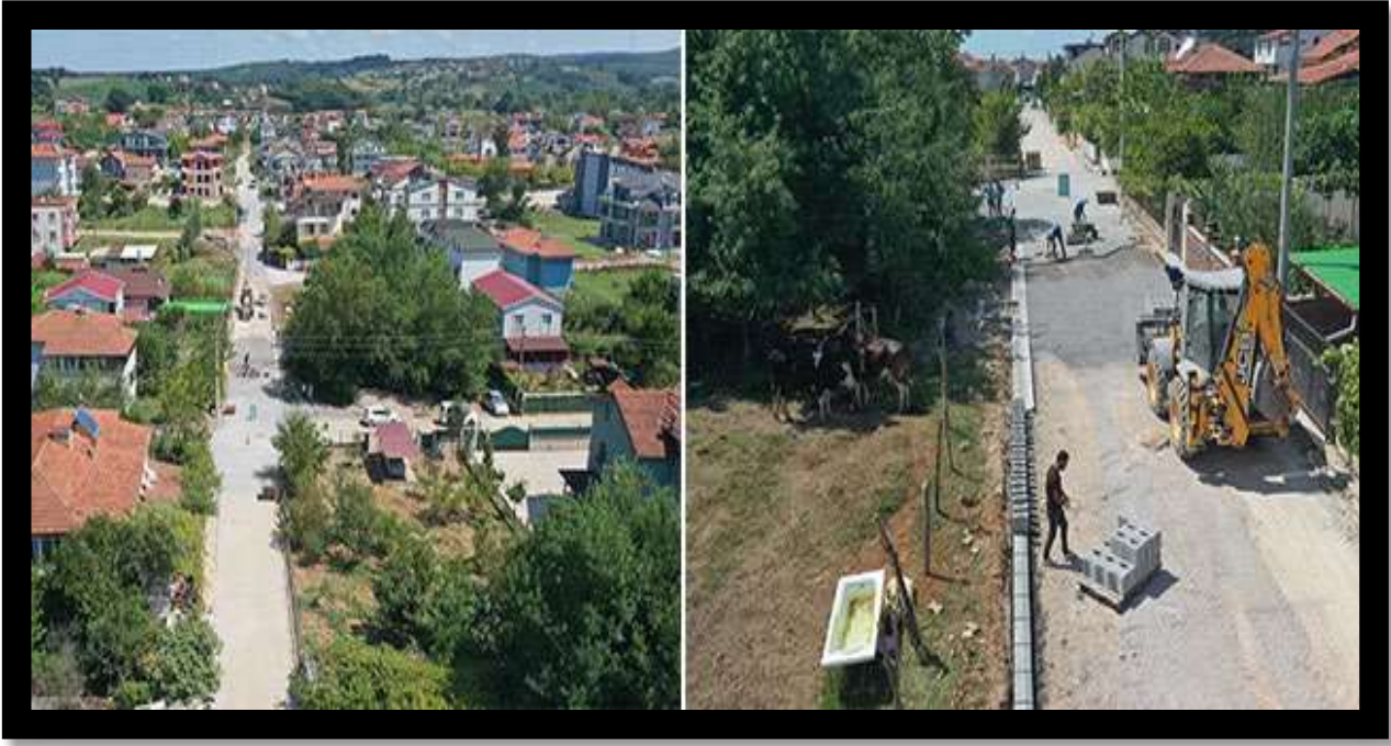
Cebeci Mahallesi Parke İmalat Çalışması
