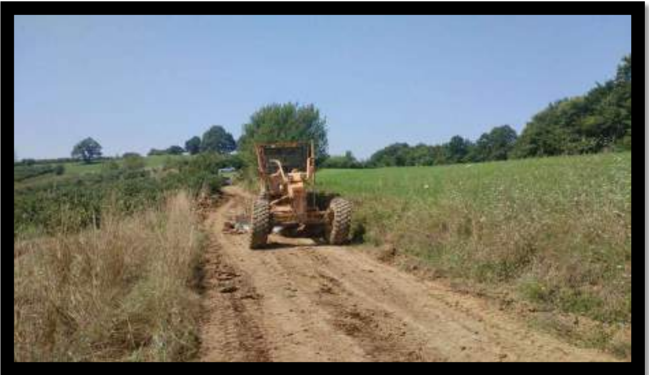
Sepetçi Mahallesi Arazi Yolu Tesviye Çalışması
