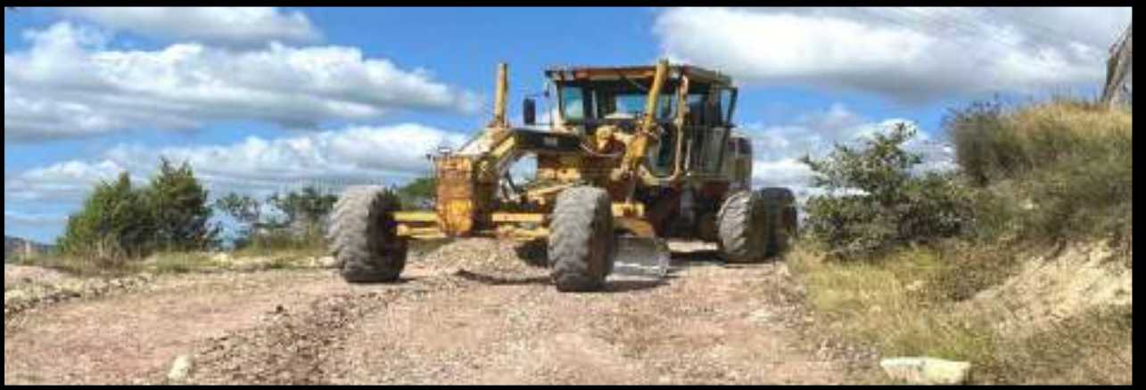
Arazi Yolu Tesviye Çalışması
