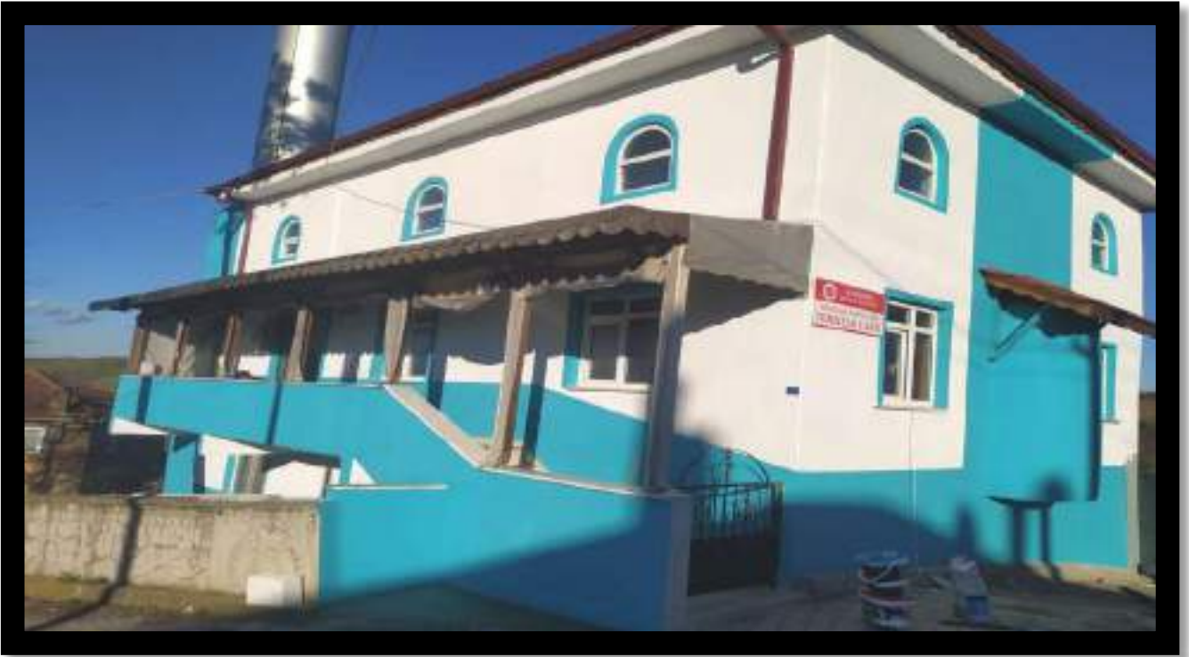
Hıdırlar Mahallesi Terziler Camii Dış Cephe Boyama Çalışması
