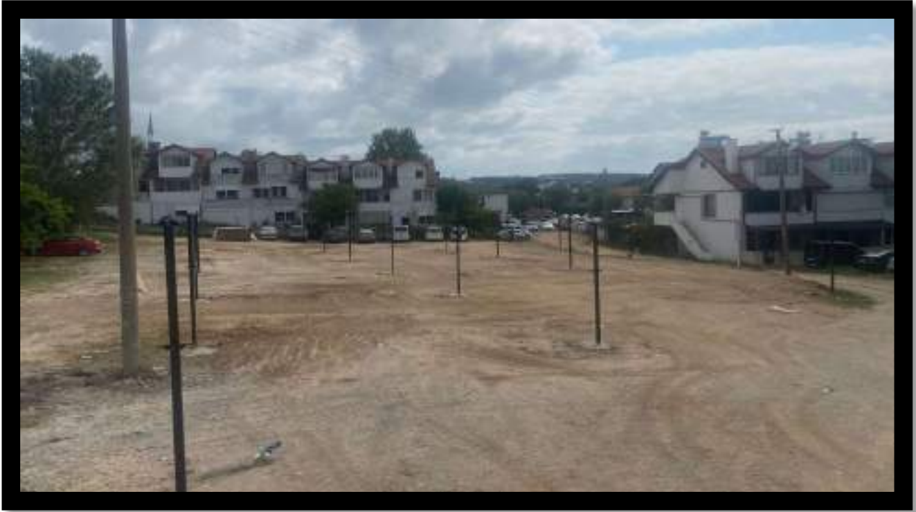
Cebeci Mahallesi Pazar Yeri Direk Montaj Çalışması
