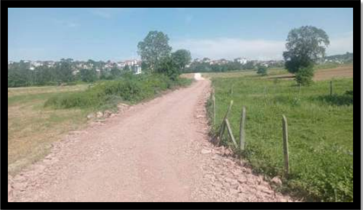
Orhan Mahallesi Stabilize Serim ve Bakım Çalışması
