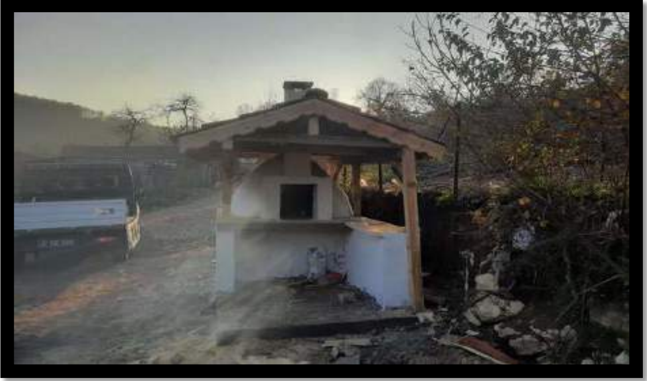
Balaban Mahallesi Çıraklı Mevkii Fırın İmalat Çalışması
