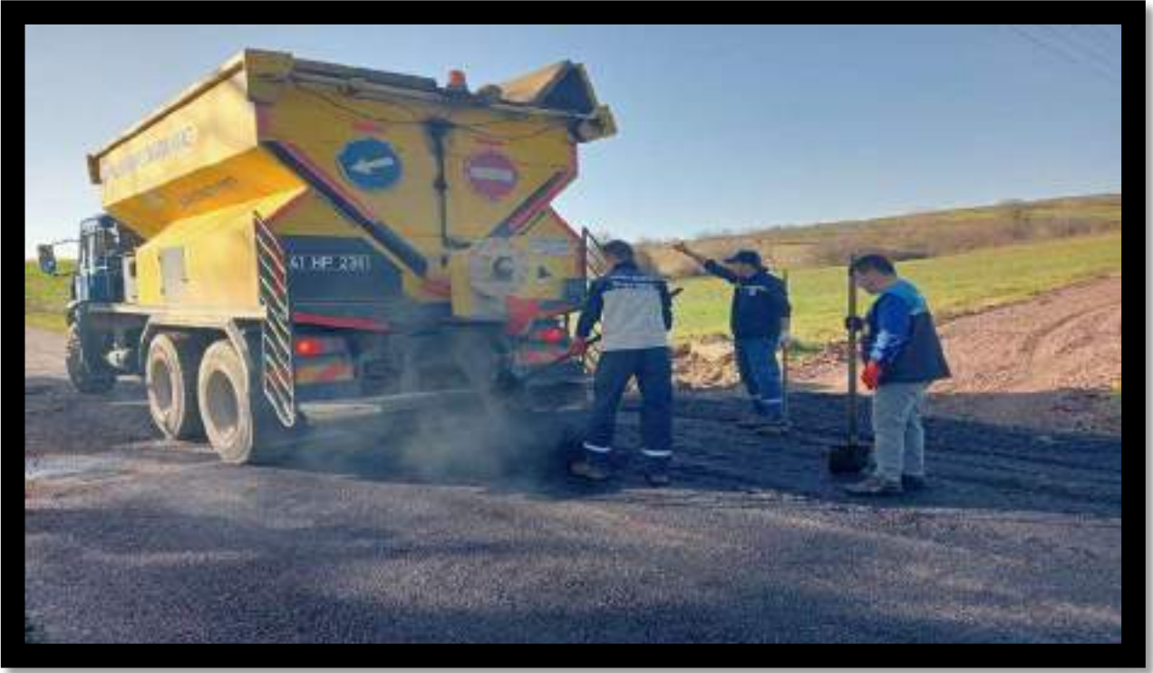
Topluca Mahallesi Asfalt Bakım Onarım Çalışması
