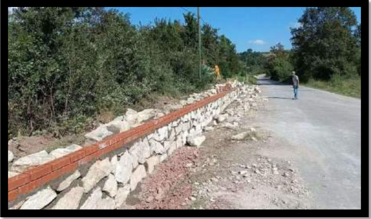
Ahmethacılar Mahallesi Mezarlık Taş Duvar İmalat Çalışması
