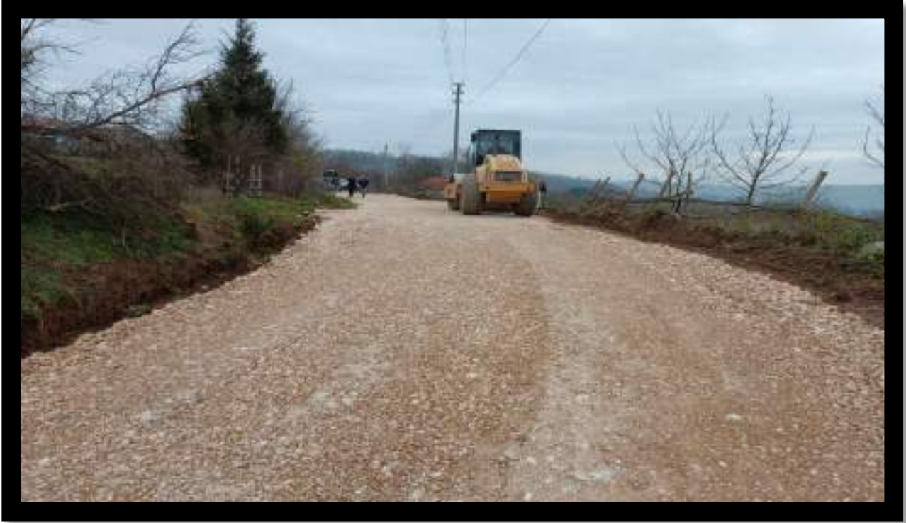
Teksen Mahallesi Malzeme Serim Çalışması
