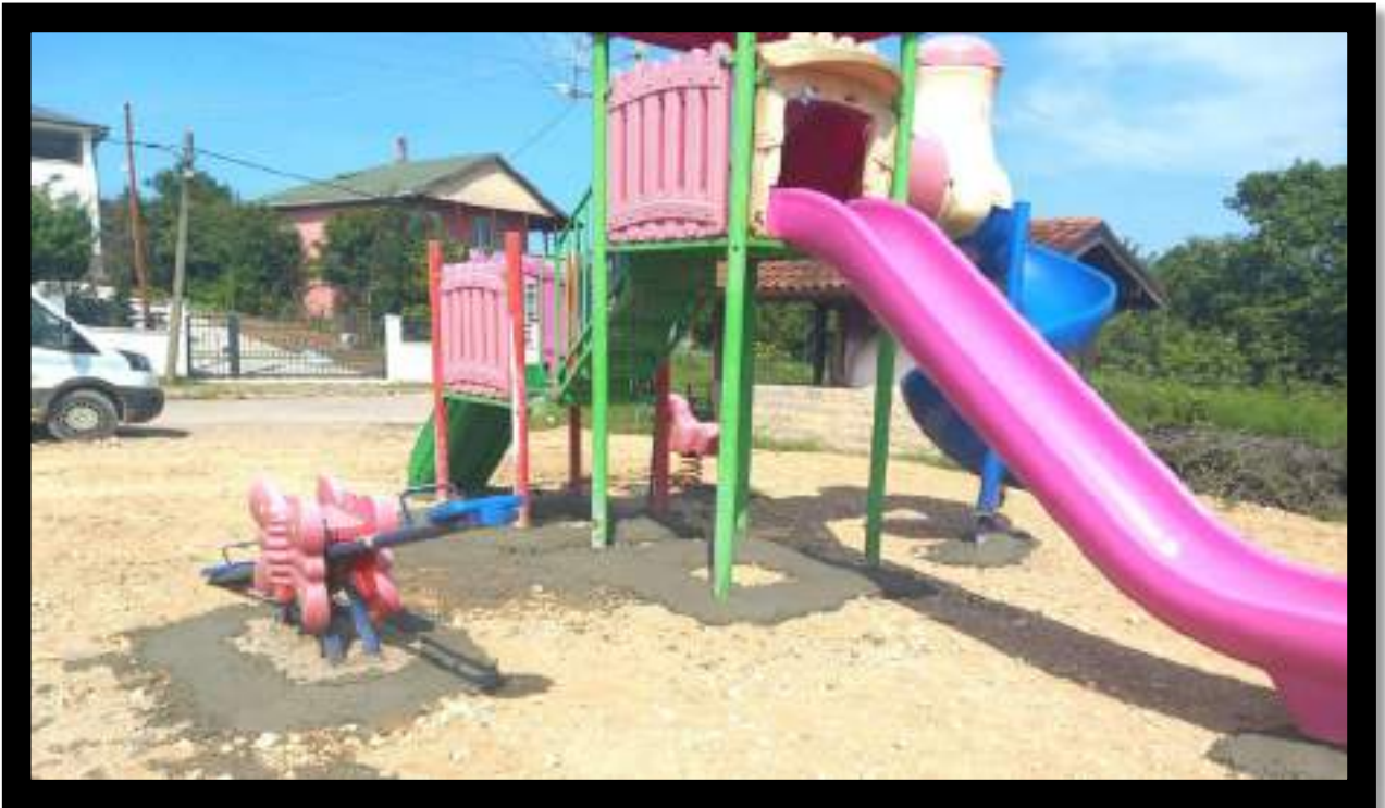
Akçabeyli Mahallesi Oyun Grubu Montaj Çalışması
