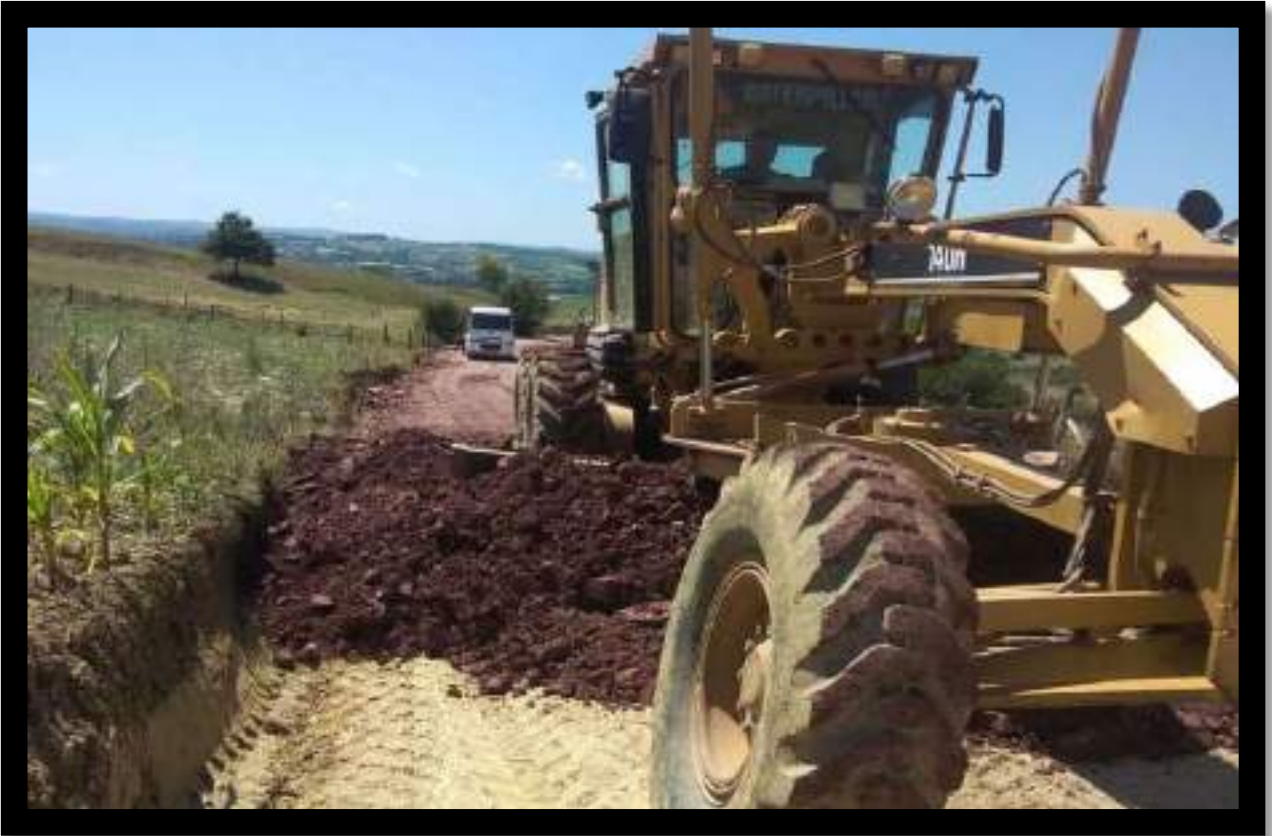
Lokmanlı Mahallesi Stabilize İmalat Çalışması
