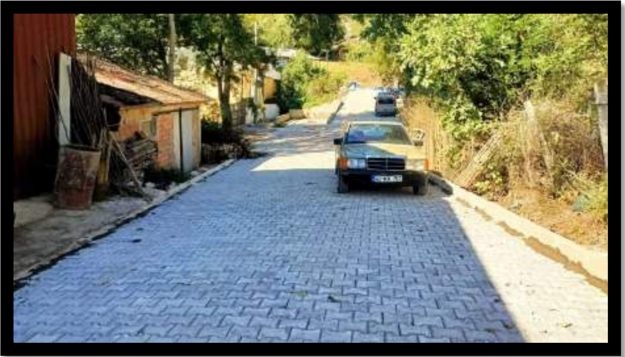
Yusufca Mahallesi Parke İmalat Çalışması
