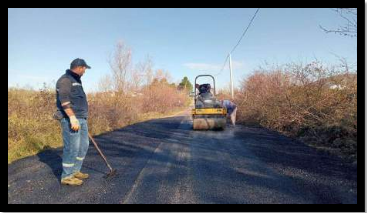
Topluca Mahallesi Asfalt Bakım Onarım Çalışması
