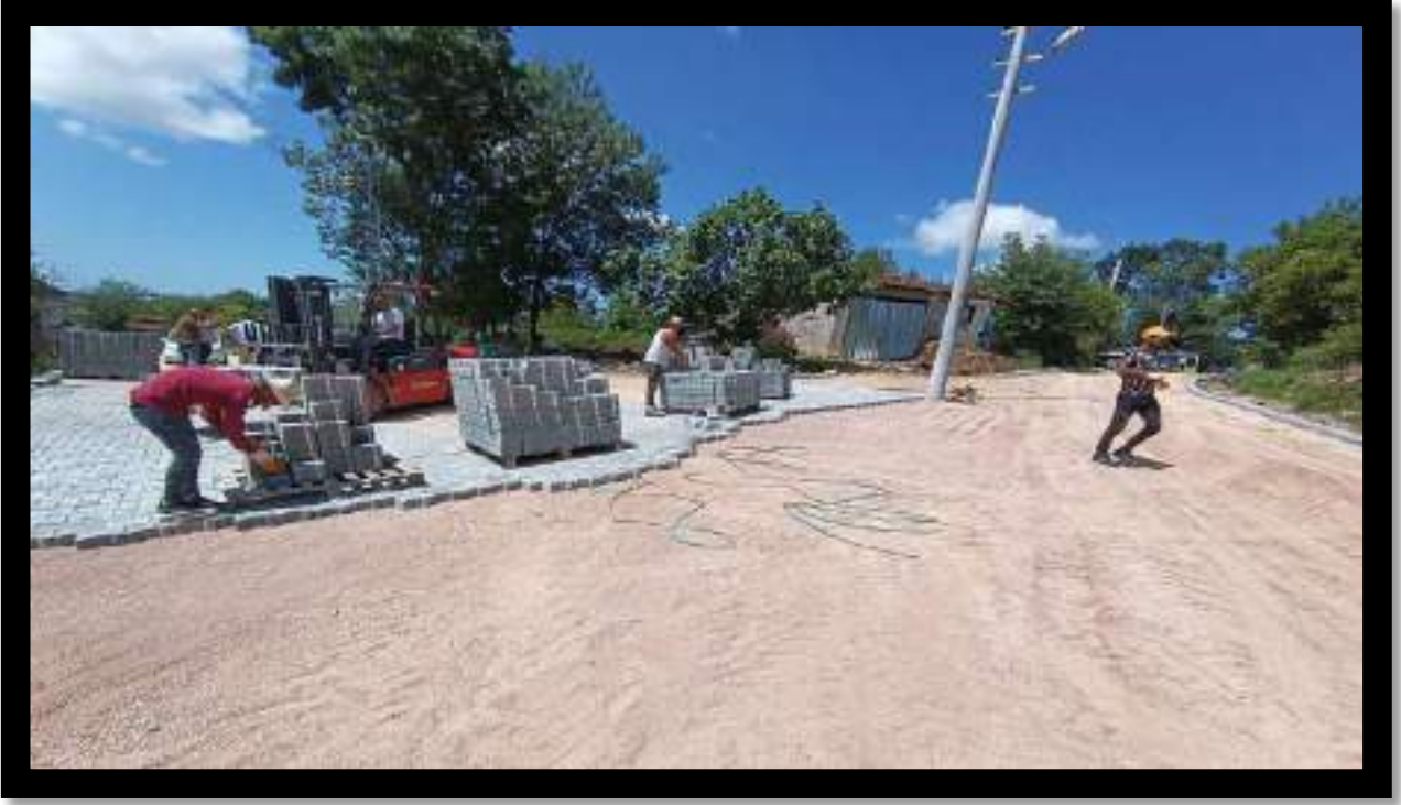
Lokmanlı Mahallesi Parke İmalat Çalışması
