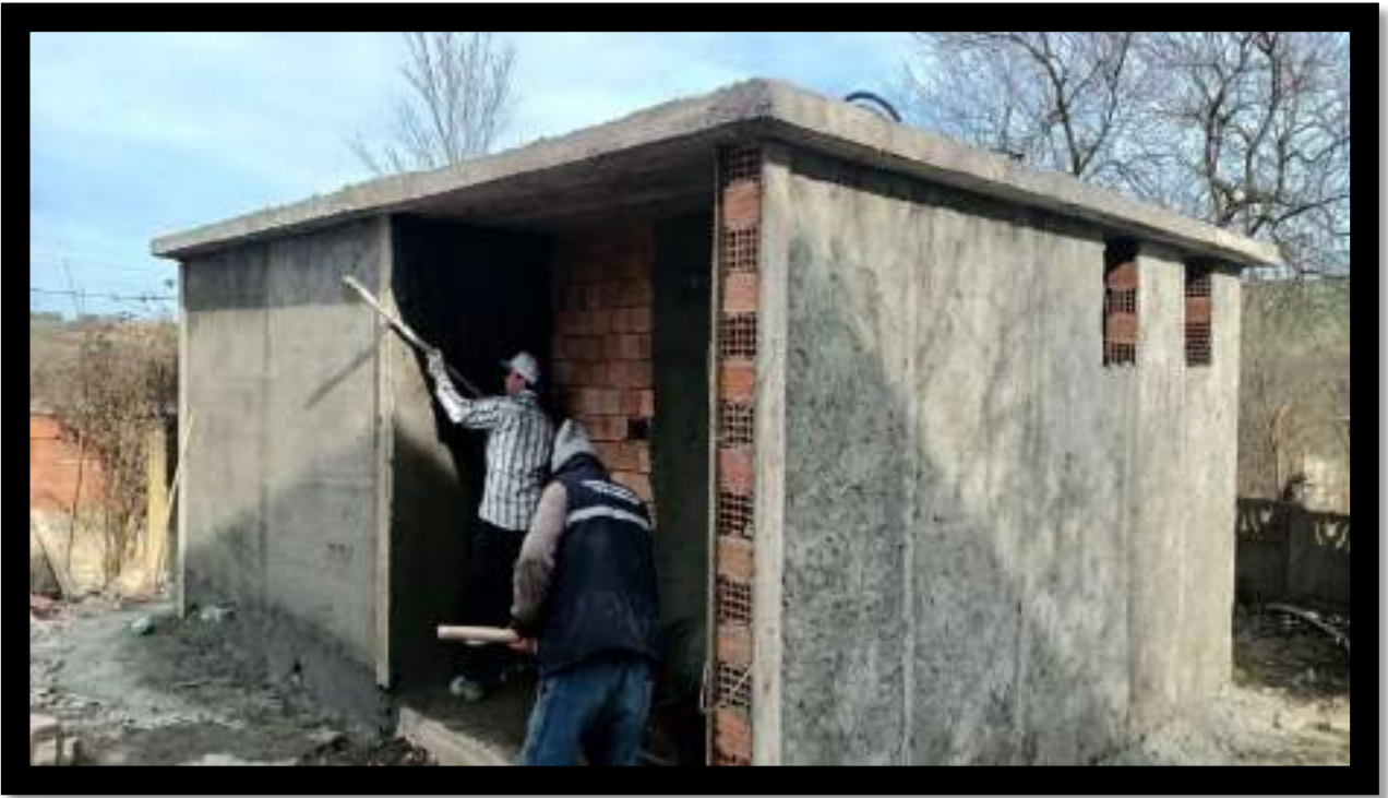
Mülküseyhsuvar Mahallesi Çaprazlar Camii Şadırvan Sıva Çalışması
