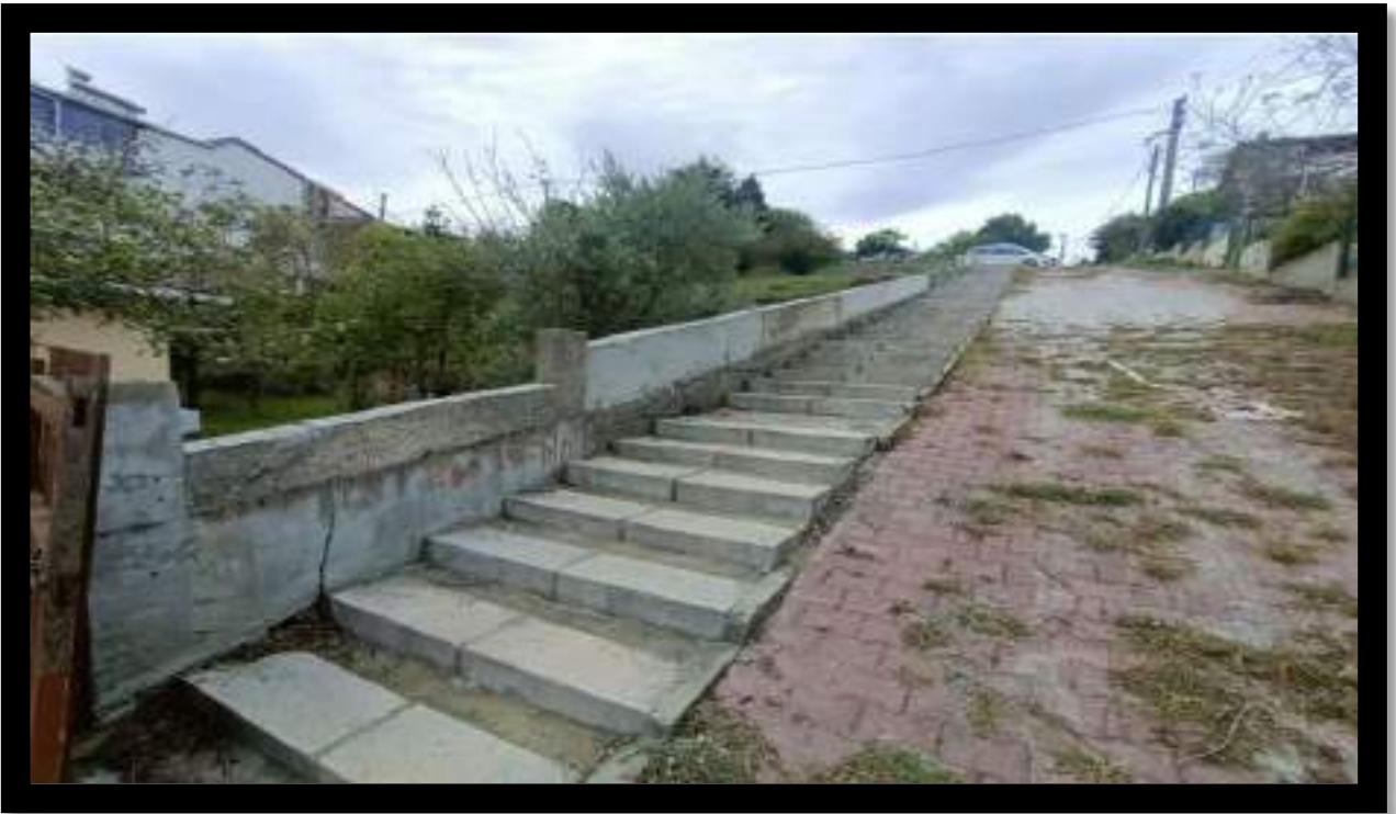
Çalköy Mahallesi Seyrek Mevkii Perde Duvar Yükseltme Çalışması
