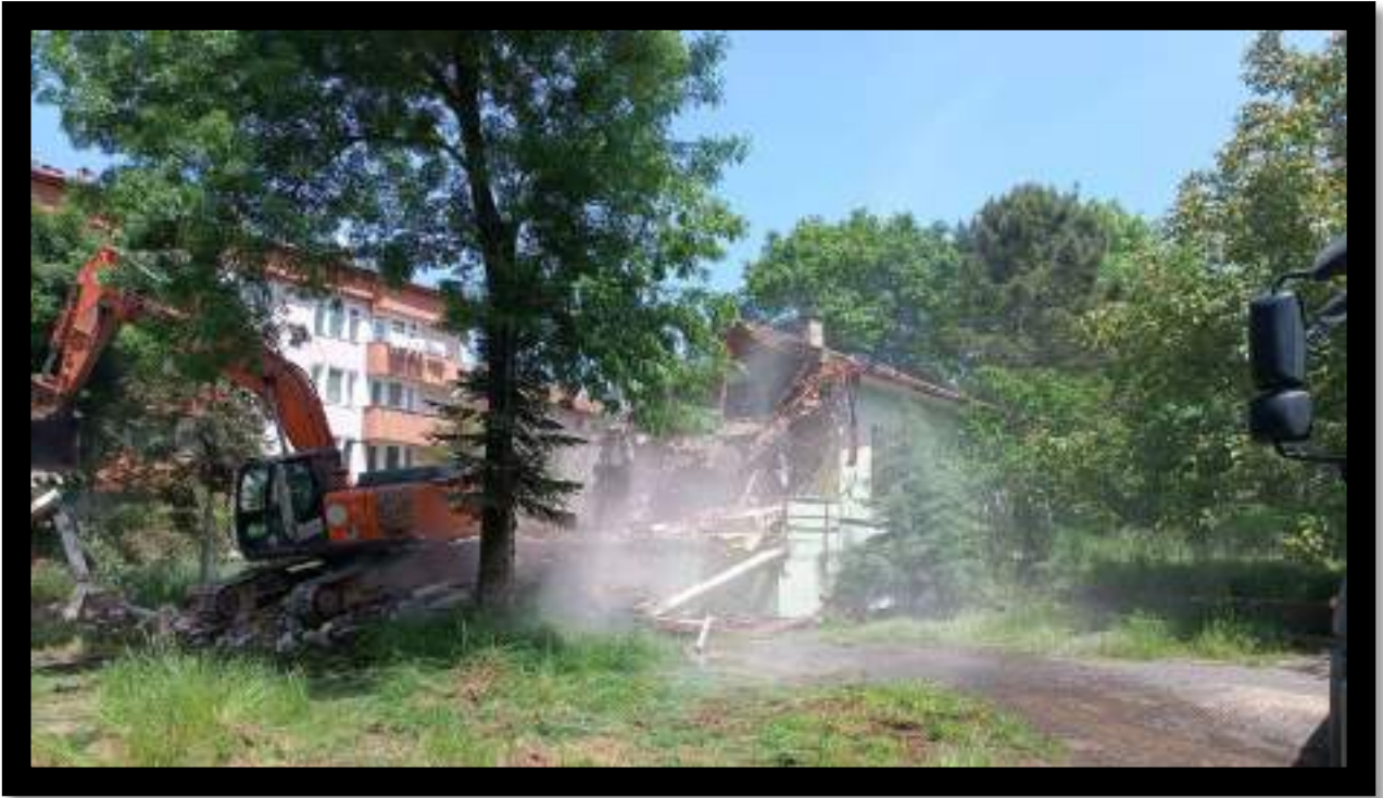
Çarşı Mahallesi Metruk Bina Yıkım Çalışması
