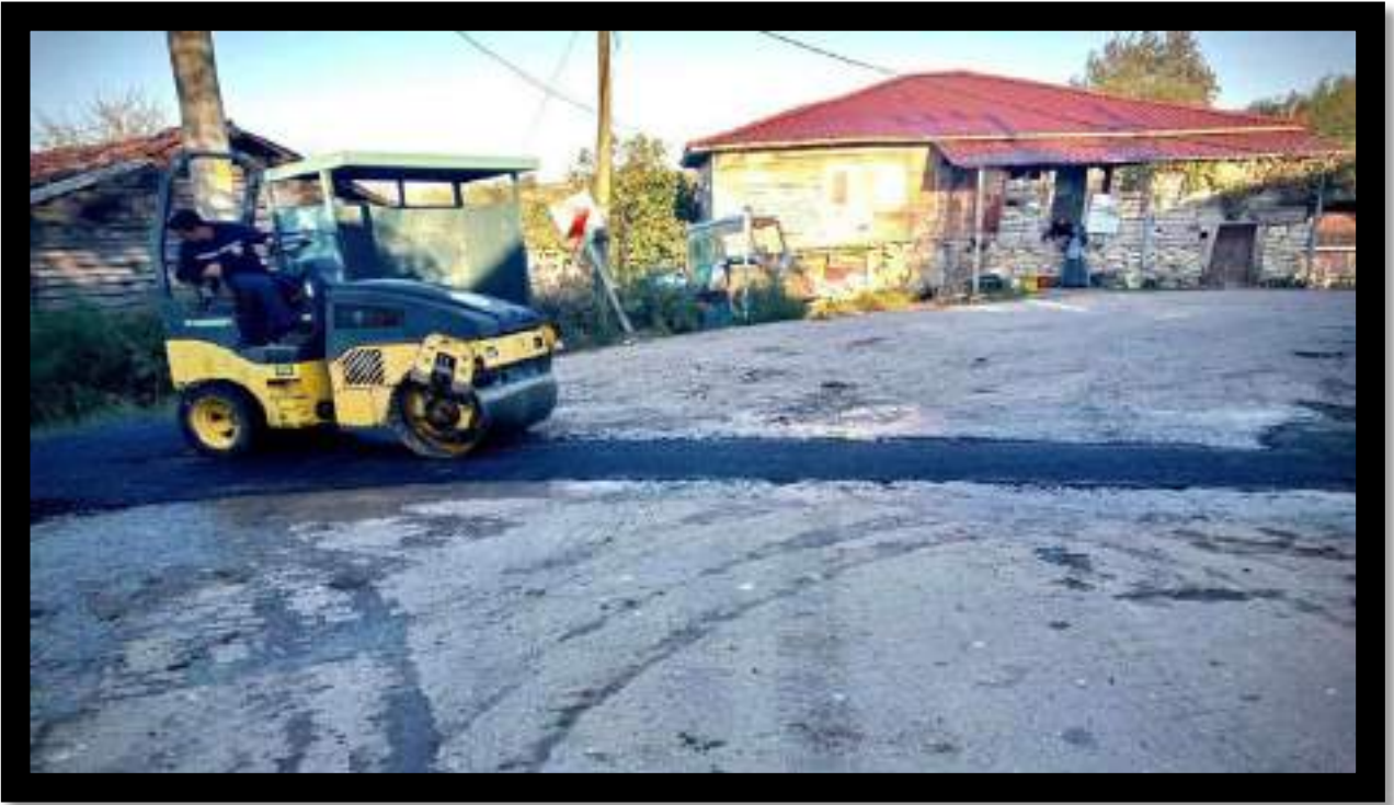
Üğümce Mahallesi Asfalt Bakım Onarım Çalışması
