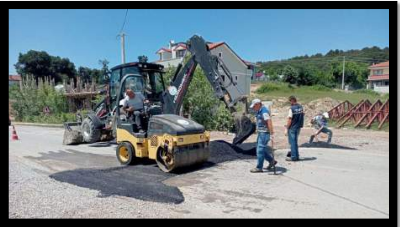
Kefken Mahallesi Asfalt Bakım Onarım Çalışması
