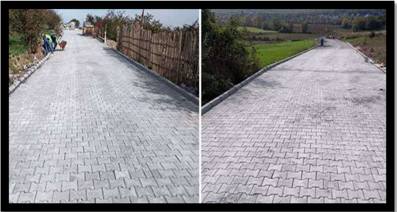
Kefken Mahallesi Parke İmalat Çalışması
