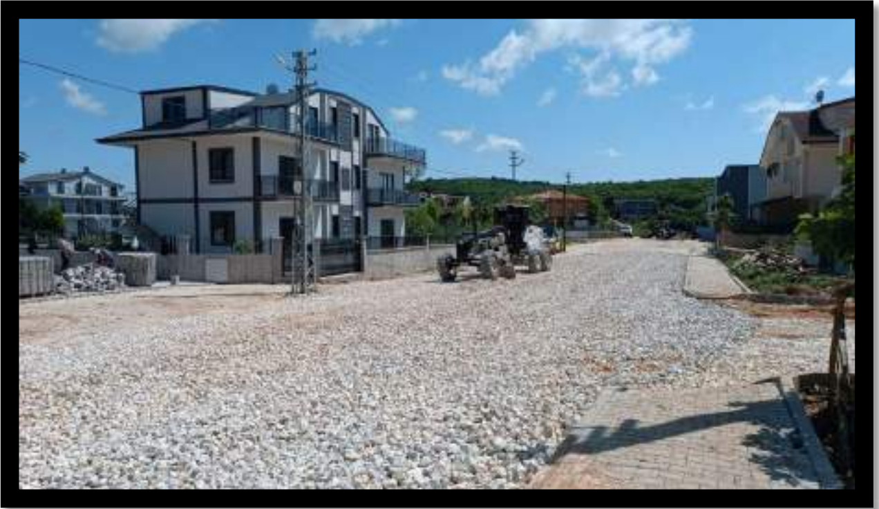
Kefken Mahallesi Malzeme Serim Çalışması
