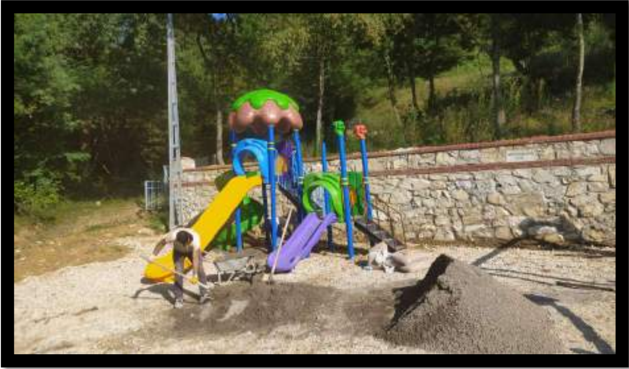
Ağaçaçıl Mahallesi Dereli Mevkii Oyun Grubu Montaj Çalışması
