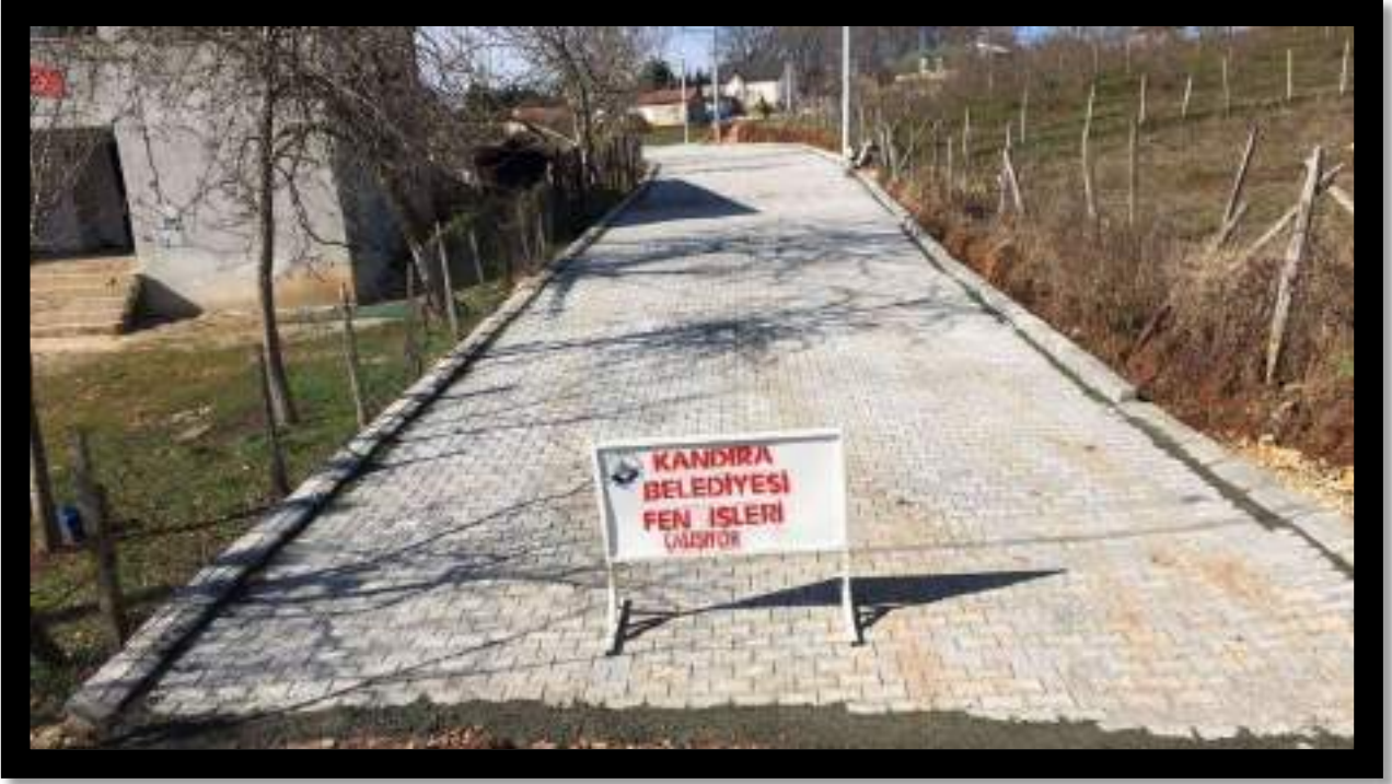
Karaağaç Mahallesi Parke İmalat Çalışması
