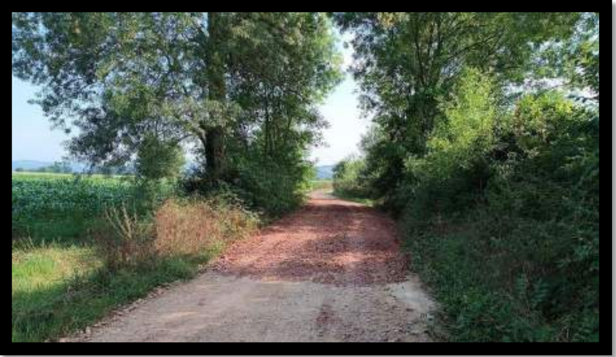
Akbal Mahallesi Stabilize Serim ve Bakım Çalışması
