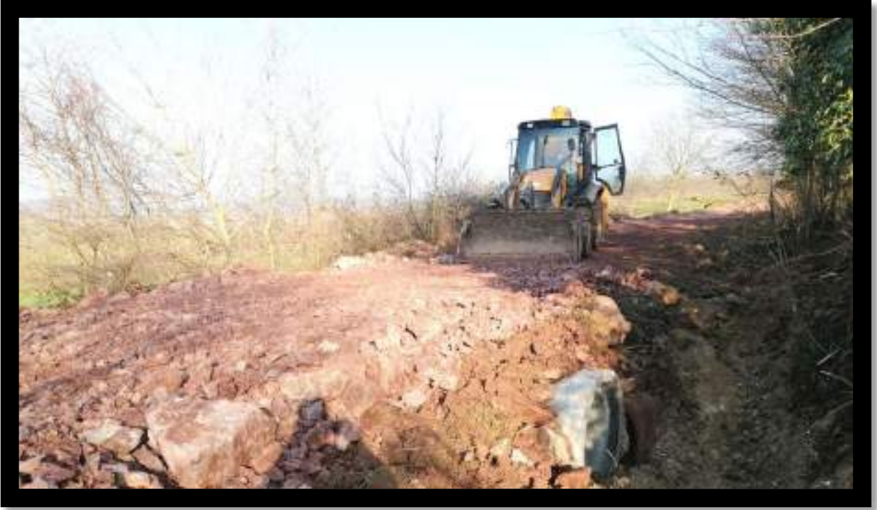
Üğümce Mahallesi Büz Koyma Çalışması
