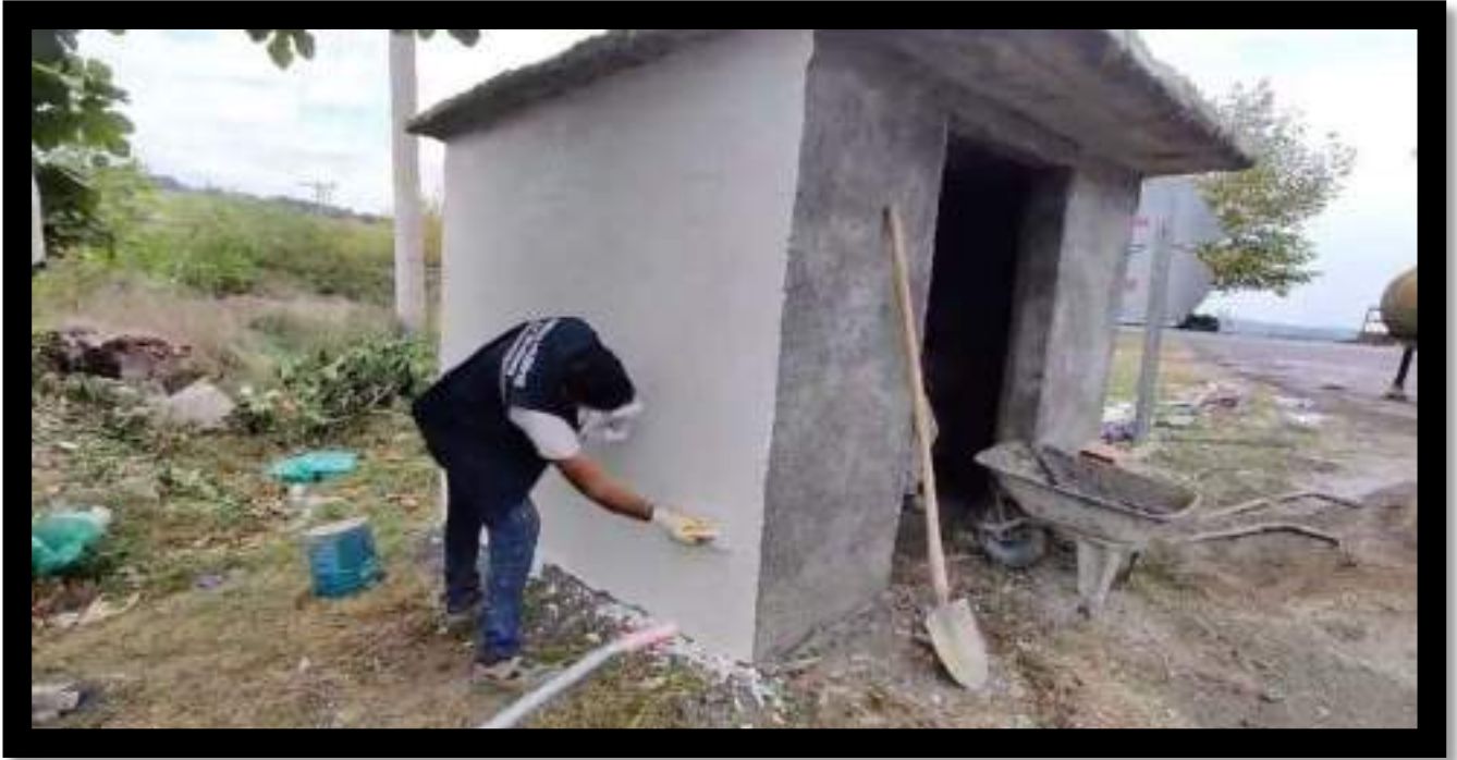
Çakırcaali Mahallesi Cicili Mevkii Durak Sıva Çalışması
