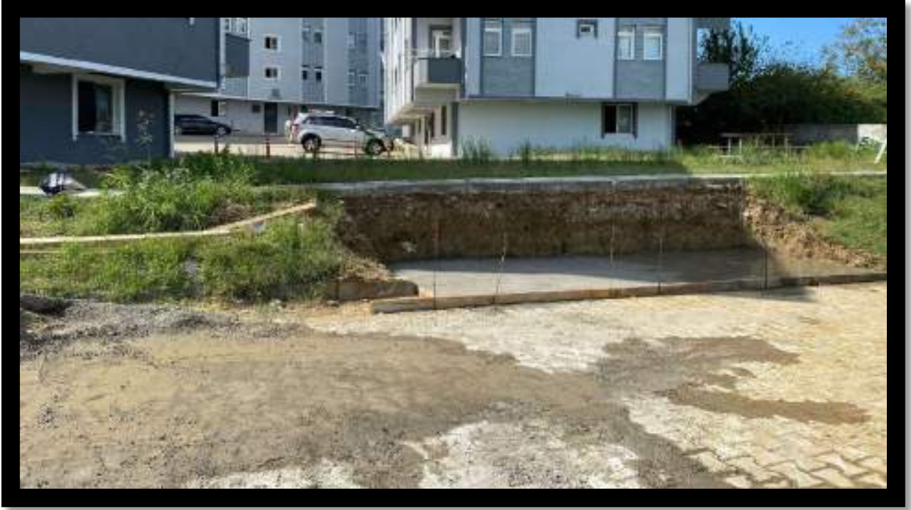
Orhan Mahallesi Durak Yeri Zemin Betonu Atma Çalışması
