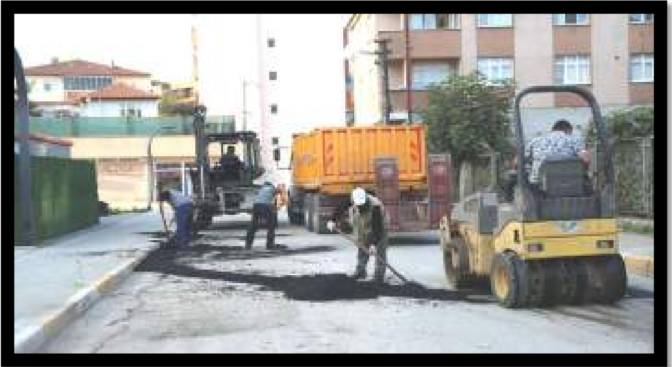
Çarşı Mahallesi Merkez Mevkii Asfalt Bakım Onarım Çalışması
