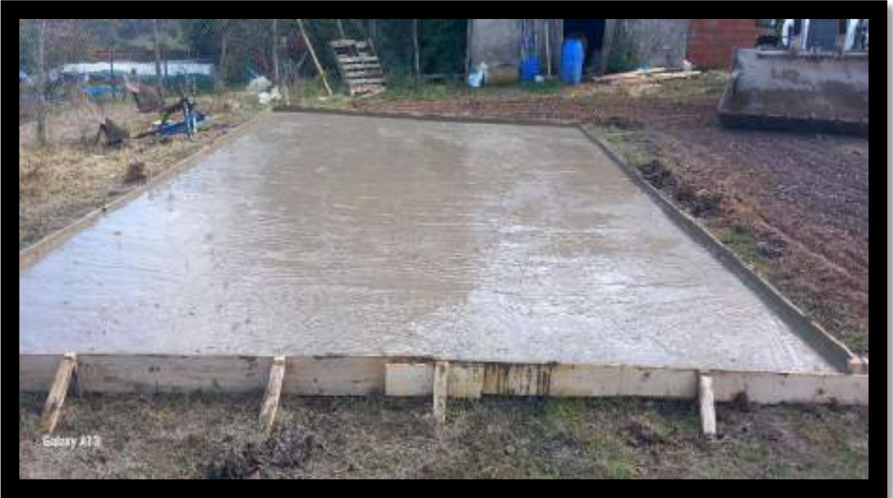
Calver Mahallesi Yanan Gariban Evi Temel Beton Çalışması
