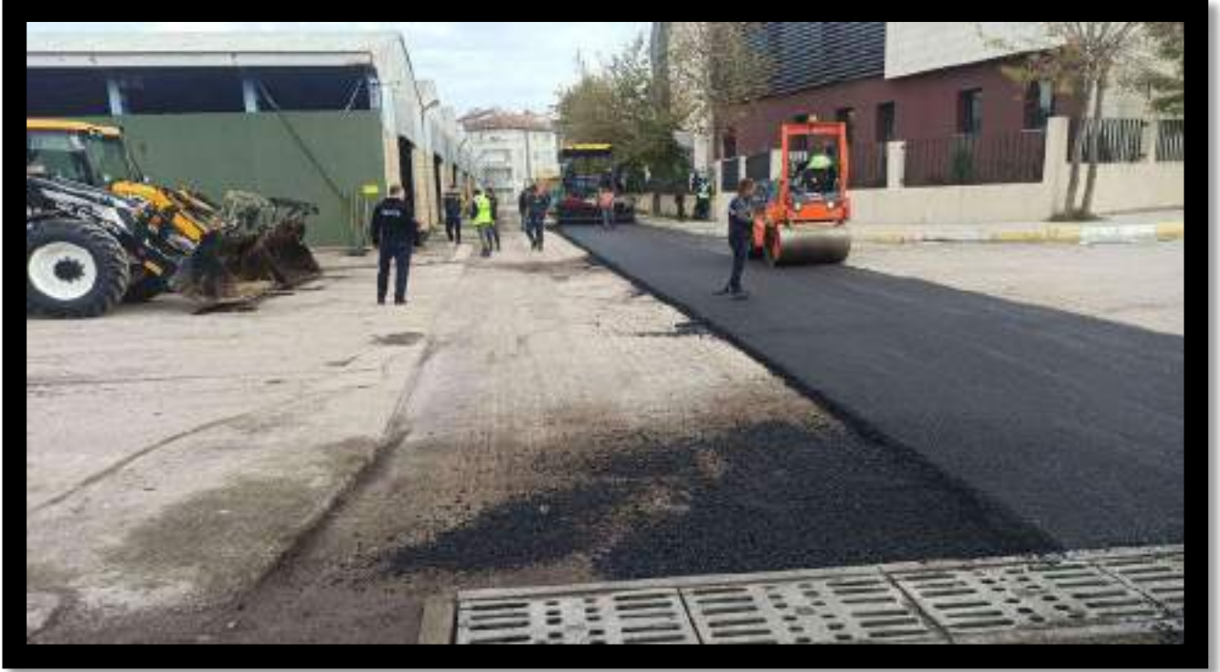
İlçe Merkezi Asfalt Yol İmalat Çalışması
