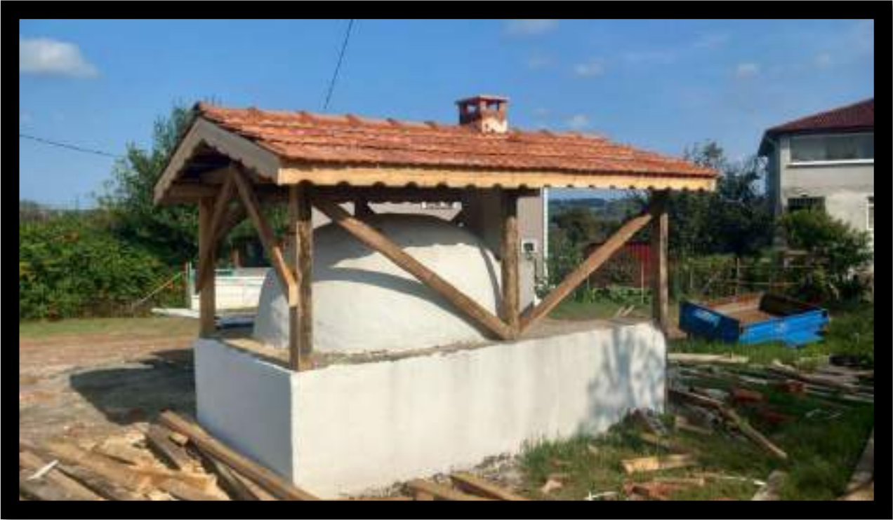
Karaağaç Mahallesi Sakalhoğlu Mevkii Fırın İmalat Çalışması
