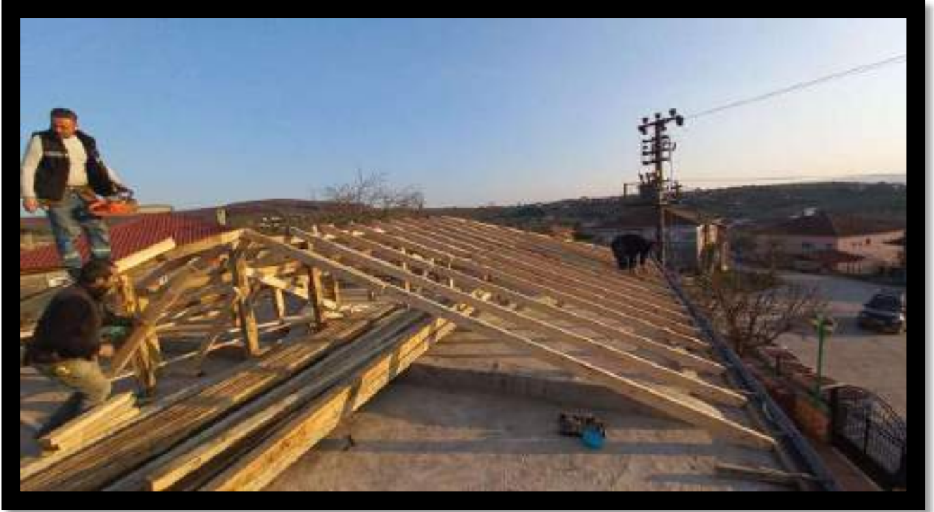
Avdan Mahallesi Merkez Camii Çatı İmalat Çalışması
