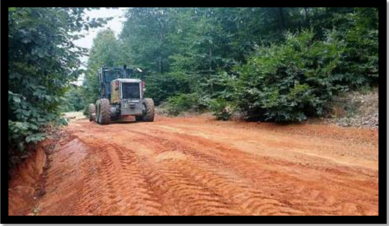
Avdan Mahallesi Arazi Yolu Tesviye Çalışması
