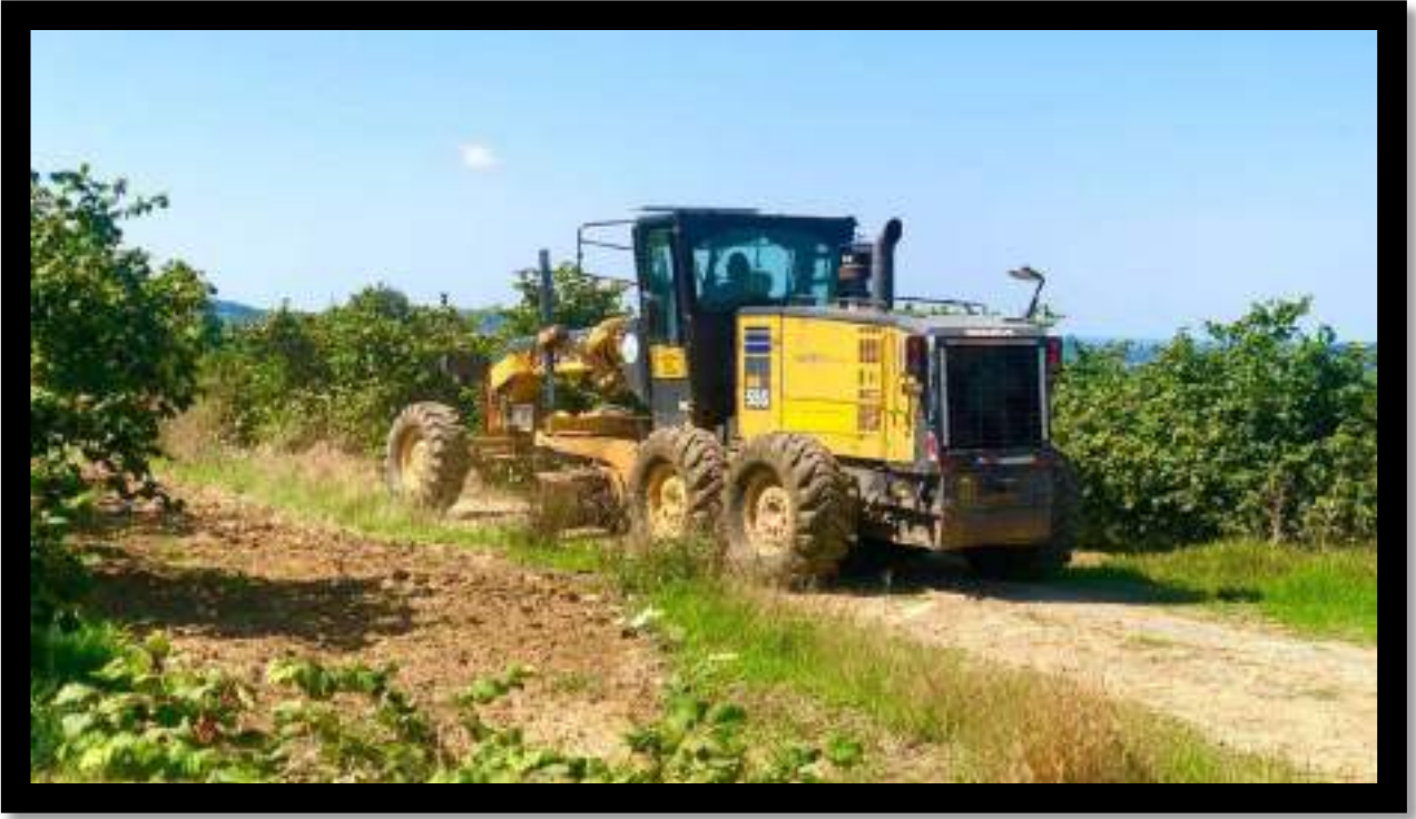
Safalı Mahallesi Arazi Yolu Tesviye Çalışması
