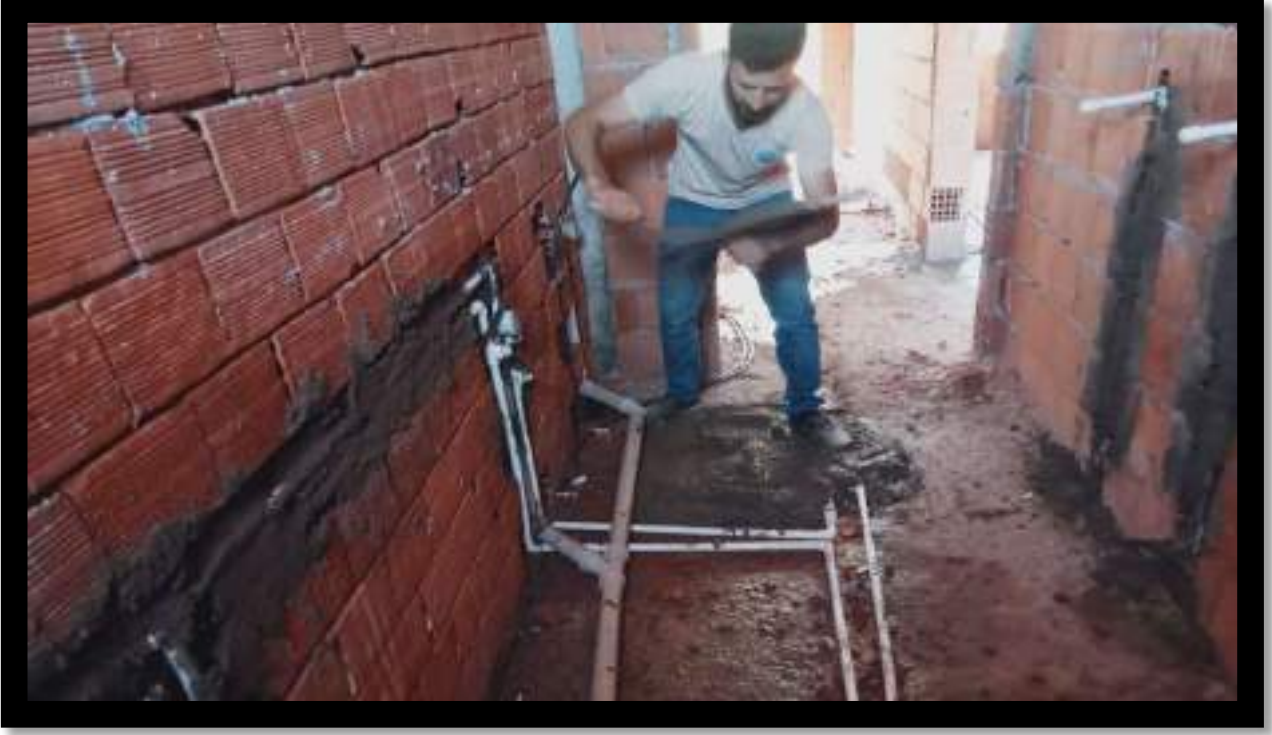
Akbal Mahallesi Ky Konađı Su Tesisatı alıřması
