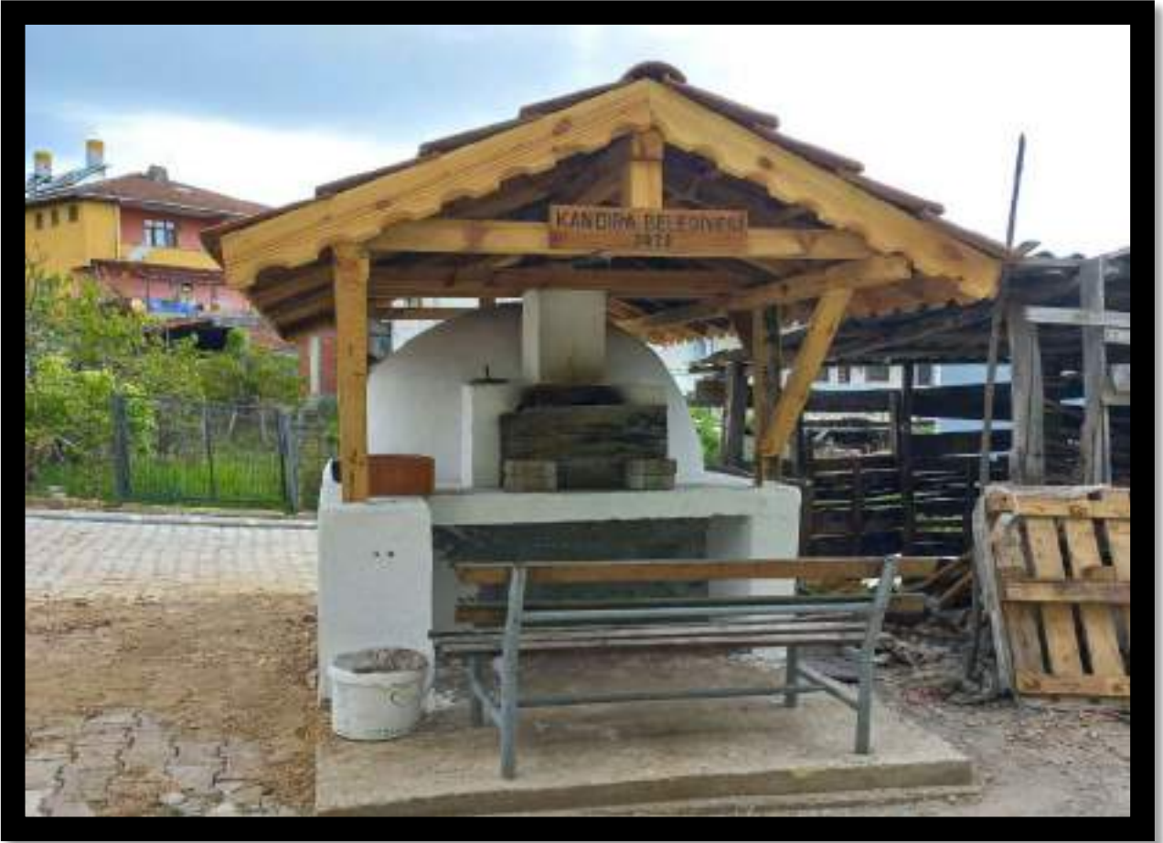
Bollu Mahallesi Fırın İmalat Çalışması
