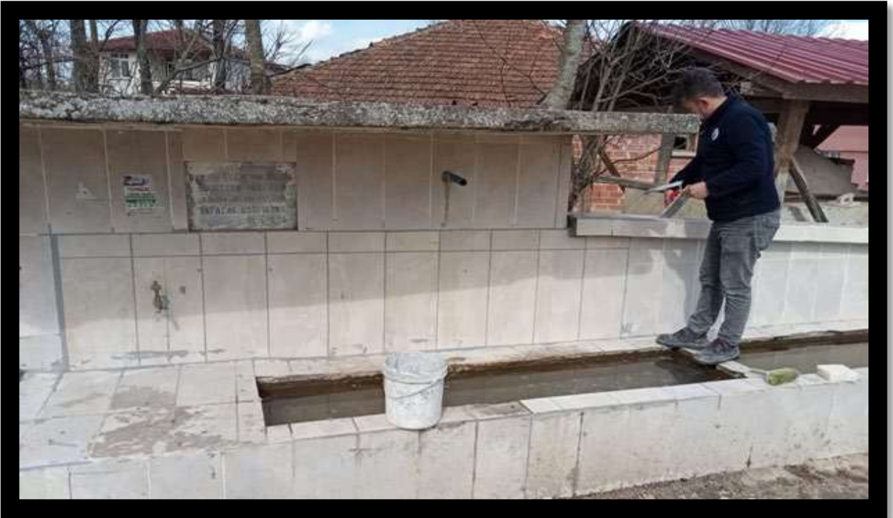
Kocakaymas Mahallesi Hacı Gaziler Mevkii Çeşme Seramik Tamirat Çalışması
