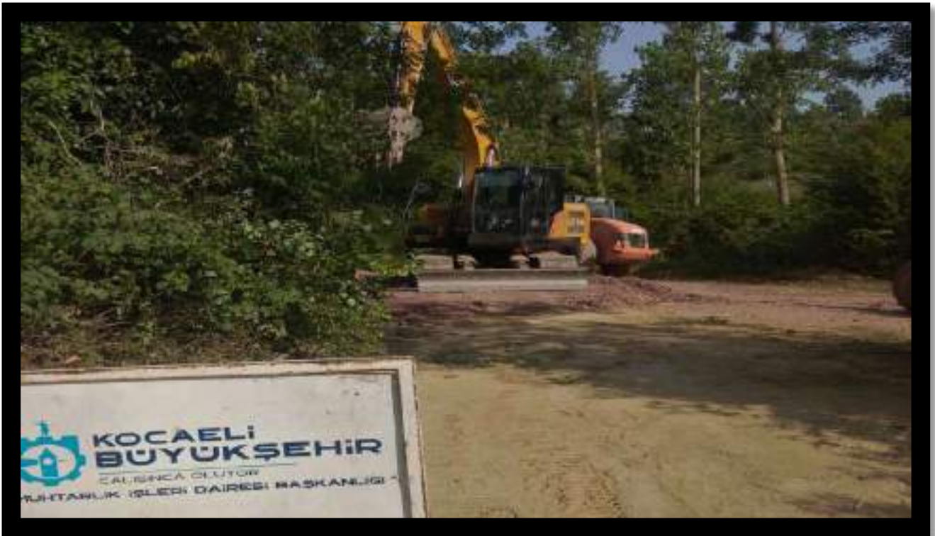
Sepetçi Mahallesi Sakallar Mevkii Stabilize İmalat Çalışması
