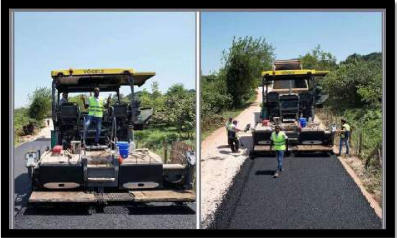
Akıncı-Çerçili Mahalleleri Arası Asfalt Yol İmalat Çalışması
