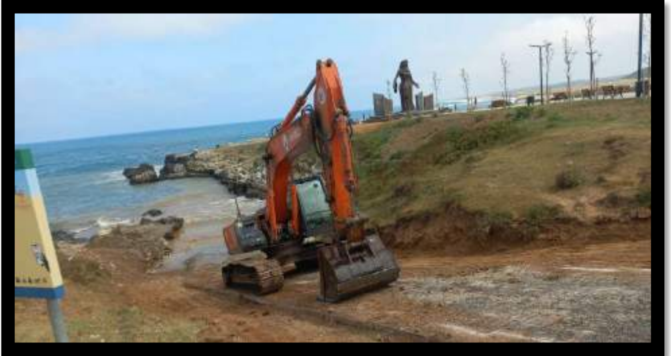
Babalı Mahallesi Ekskavatör Çalışması
