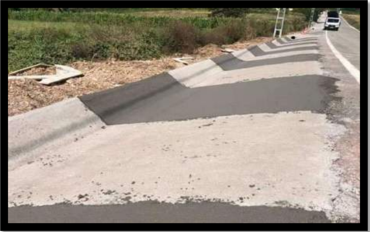
Kırkarmut Mahallesi V Kanal İmalat Çalışması
