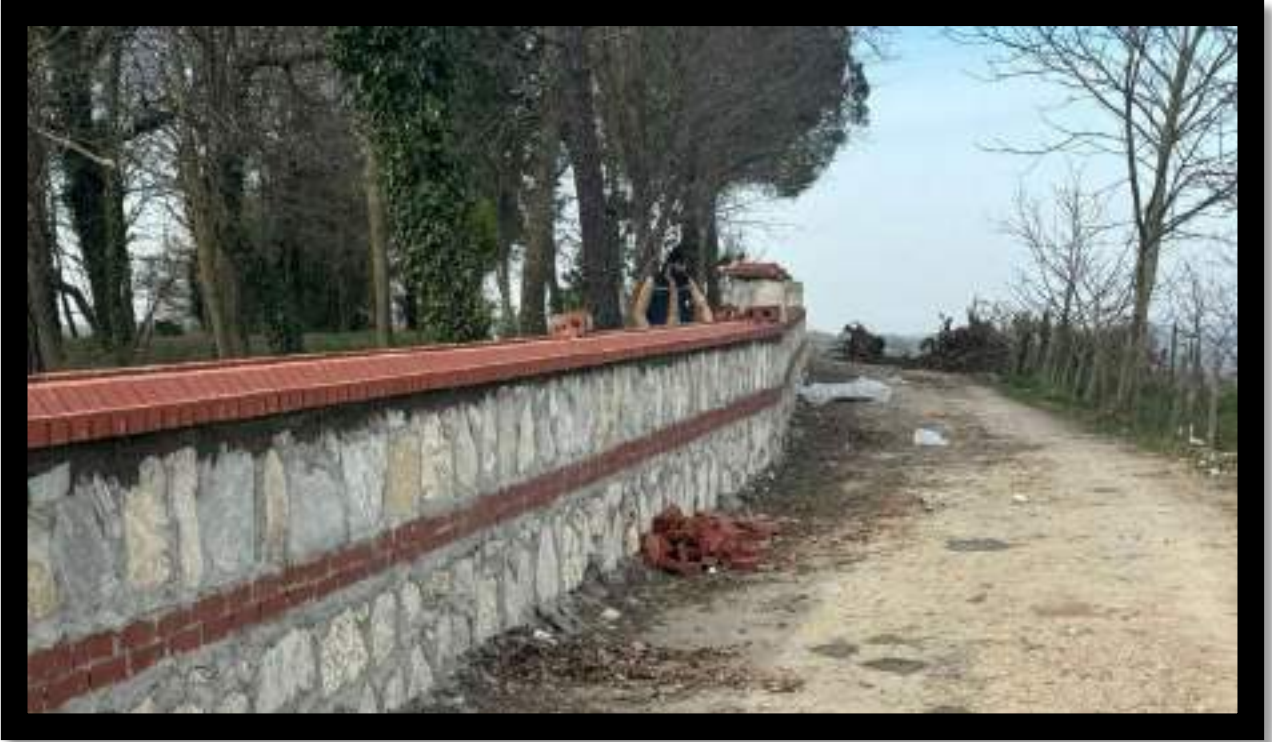
Balcı Mahallesi Mezarlık Taş Duvar İmalat Çalışması
