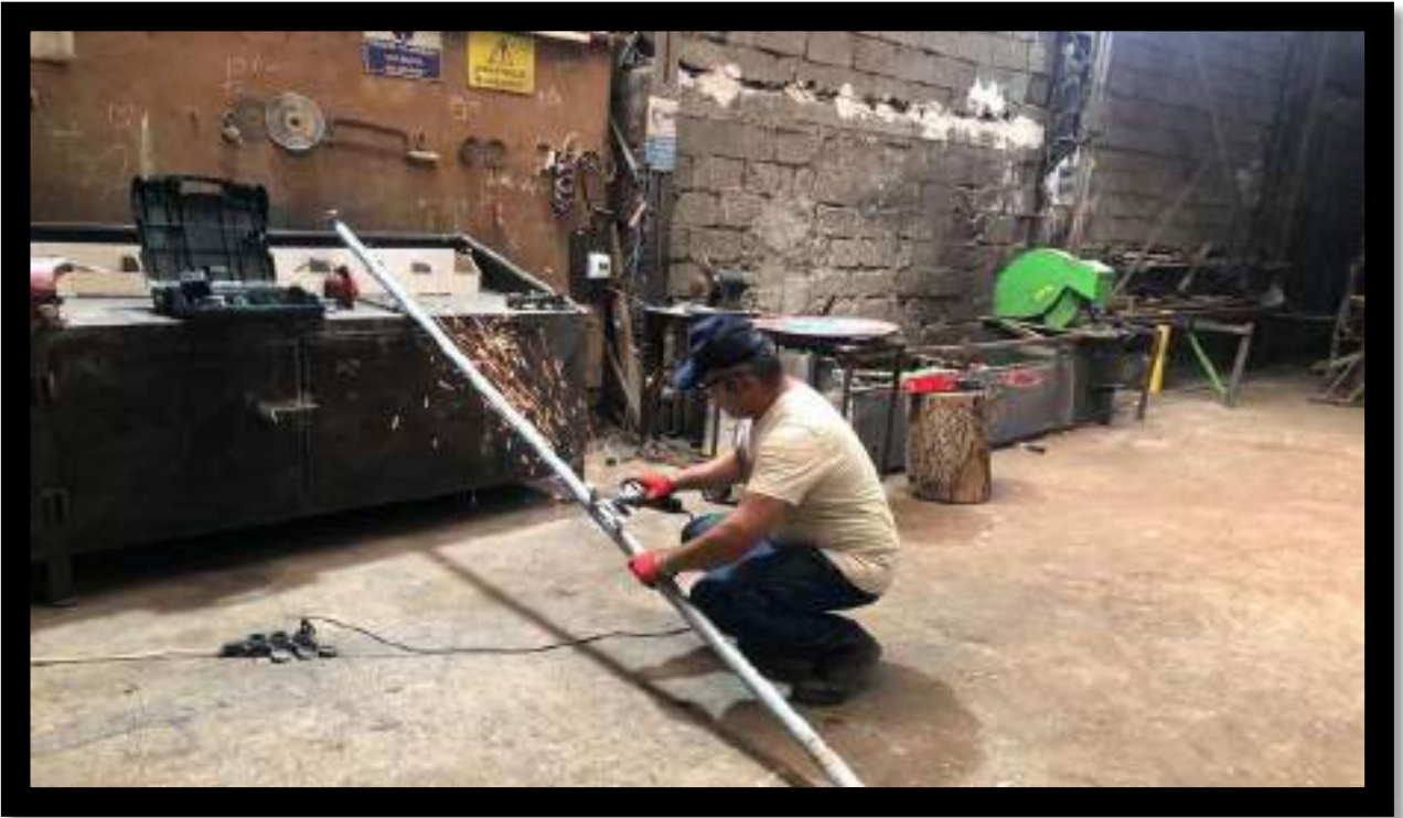
Kaynak Atölyesi Çalışmaları
