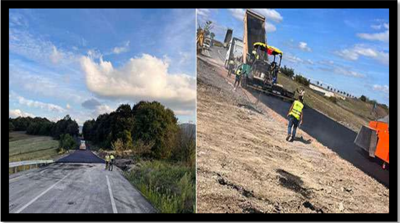
Akçakese Mahallesi Asfalt Yol İmalat Çalışması
