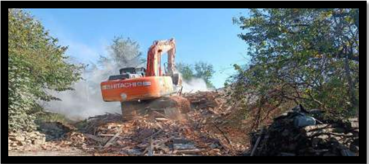
Sinanlı Bilalli Mahallesi Metruk Bina Yıkım Çalışması
