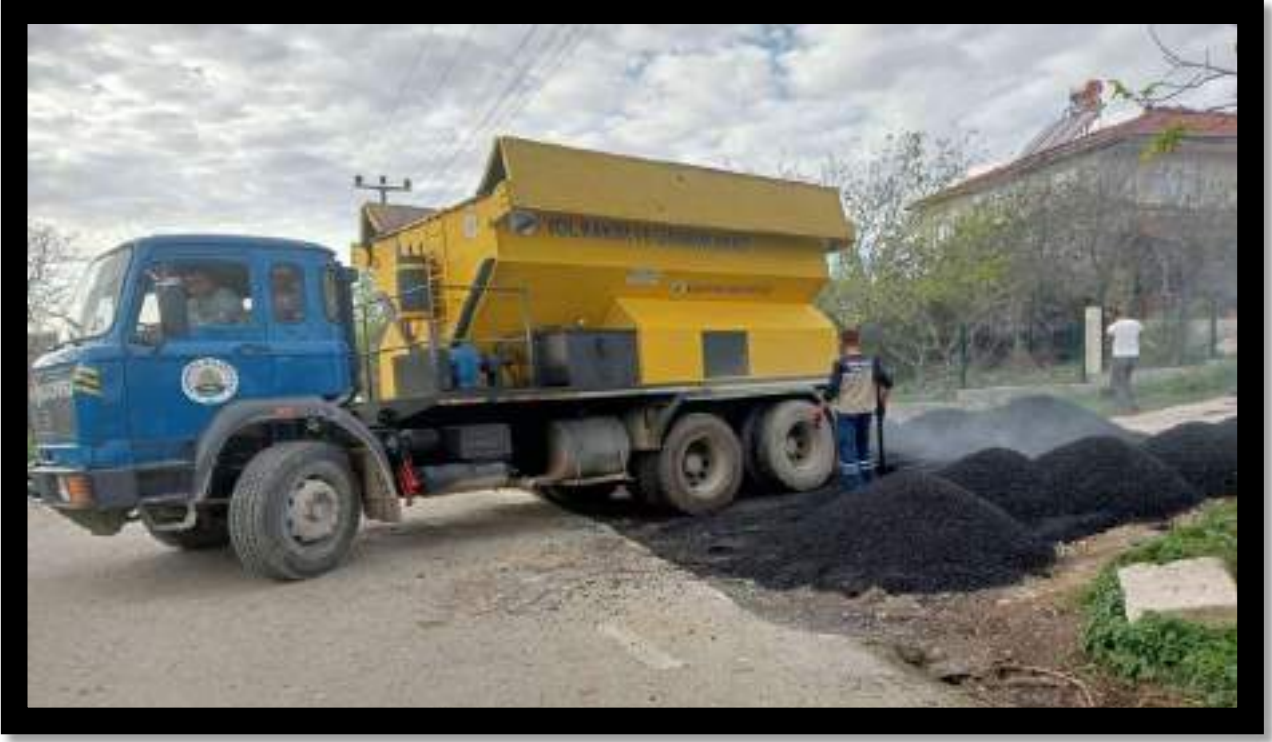
Özbeý Mahallesi Asfalt Bakım Onarım Çalışması
