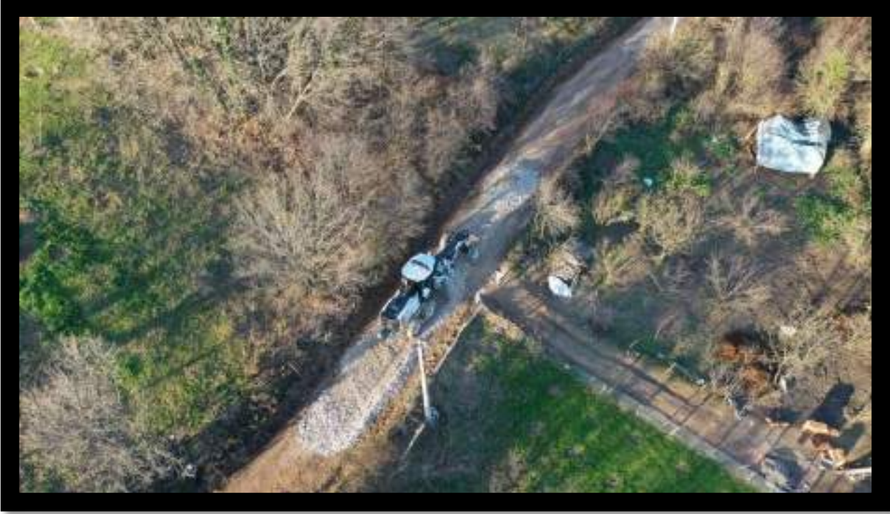
Teksen Mahallesi Malzeme Serim Çalışması
