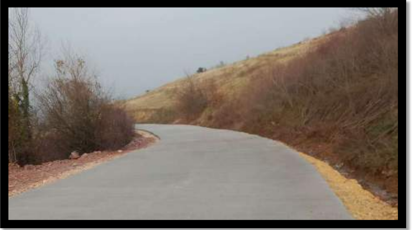
Pirceler Mahallesi Beton Yol İmalat Çalışması
