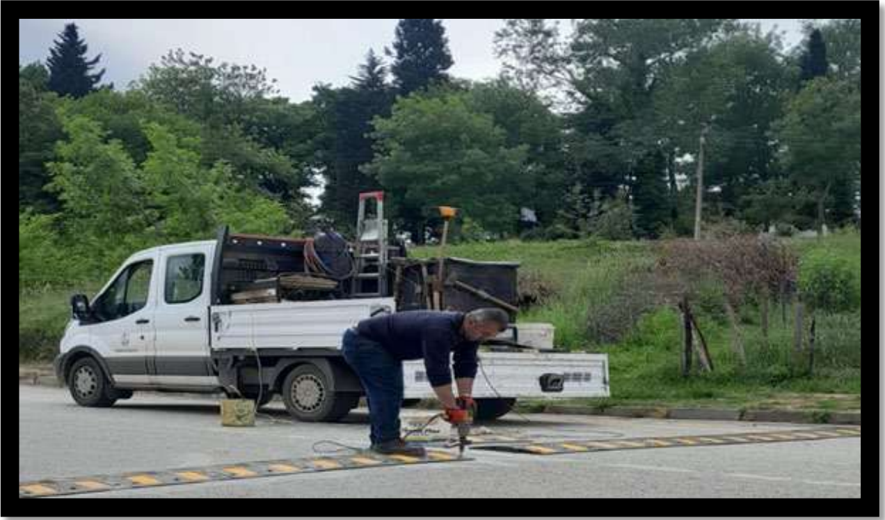
Akdurak Mahallesi Ilca Caddesi Kasis Montaj Çalışması
