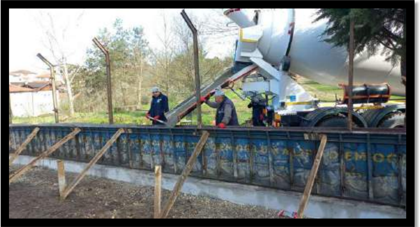
Akdurak Mahallesi İhata Duvarı İmalat Çalışması
