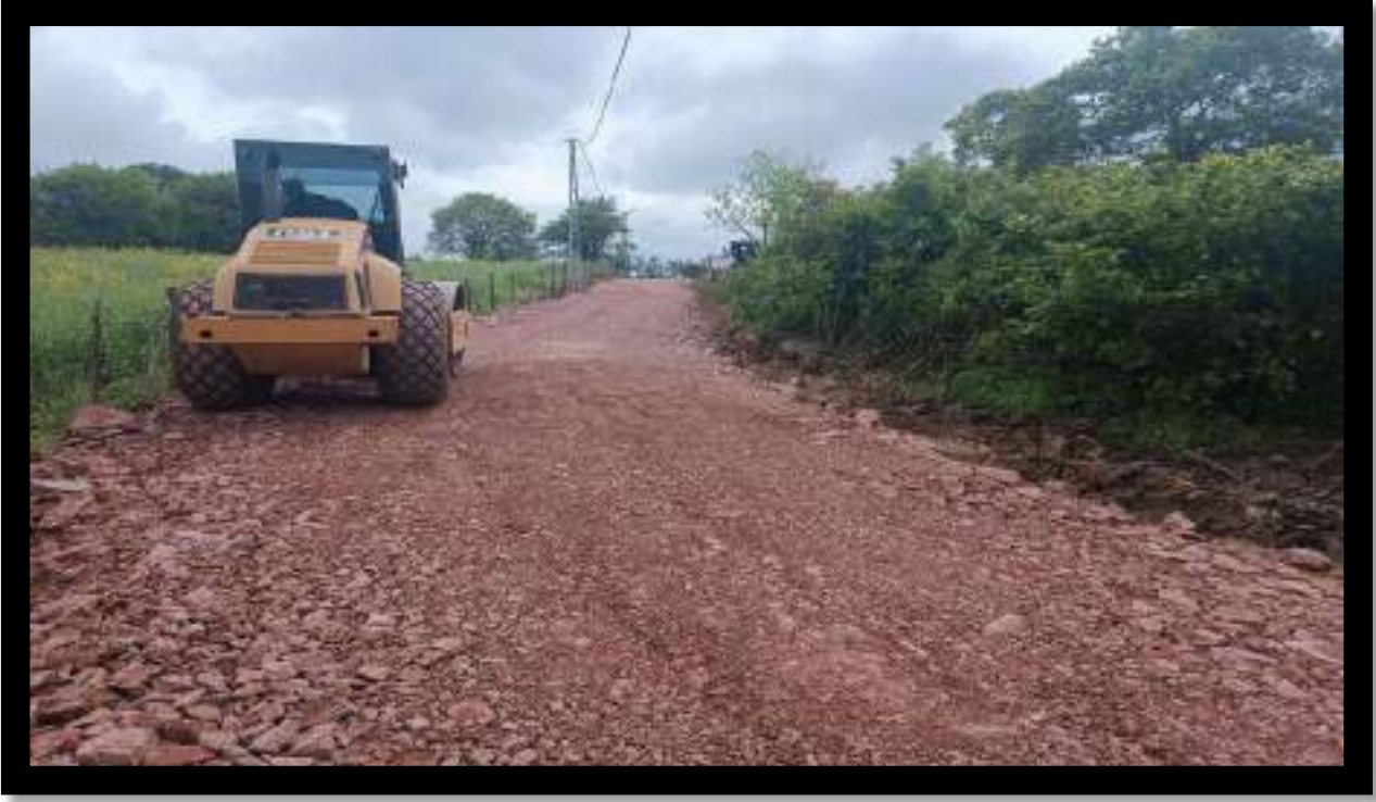
Çalköy Mahallesi Stabilize Serim ve Bakım Çalışması
