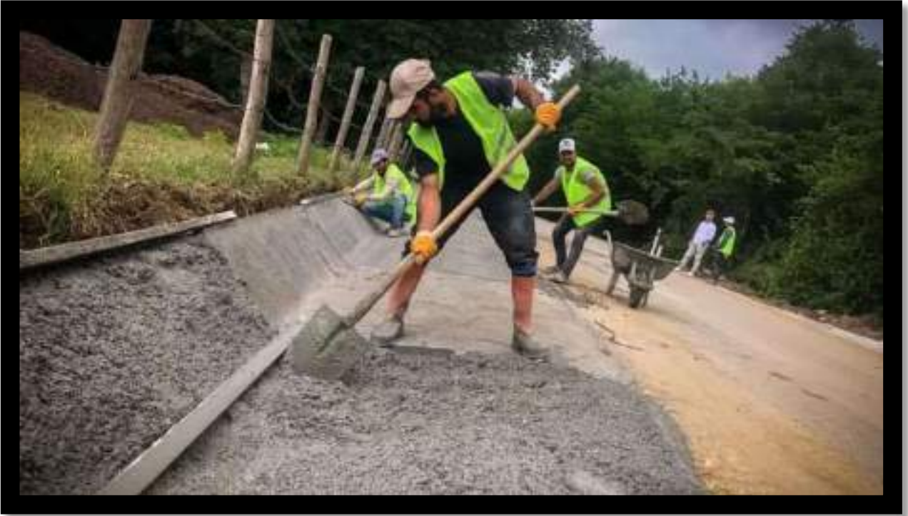
Kabağaç Mahallesi V Kanal İmalat Çalışması
