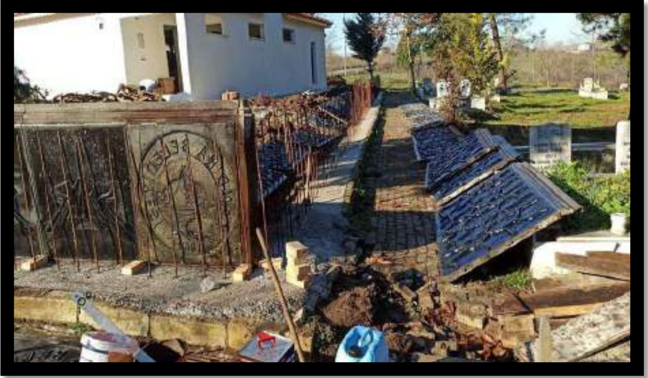
Orhan Mahallesi Asri Mezarlık Gasilhane Etrafı Beton Duvar Çalışması
