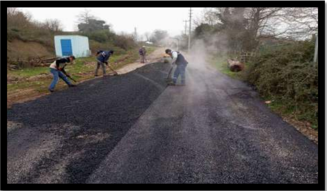
Kaymaz Araman Mahallesi Asfalt Bakım Onarım Çalışması
