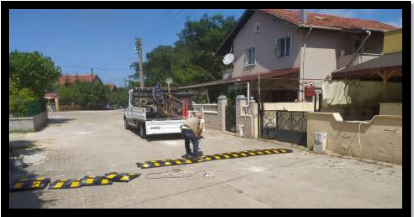
Kefken Mahallesi Merkez Mevkii Kasis Montaj Çalışması
