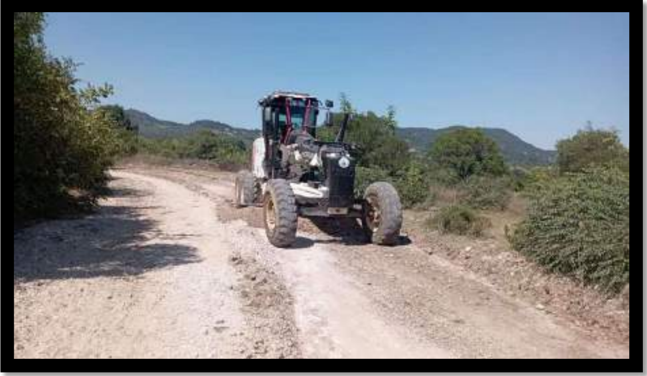
Kızılcapınar Mahallesi Arazi Yolu Tesviye Çalışması
