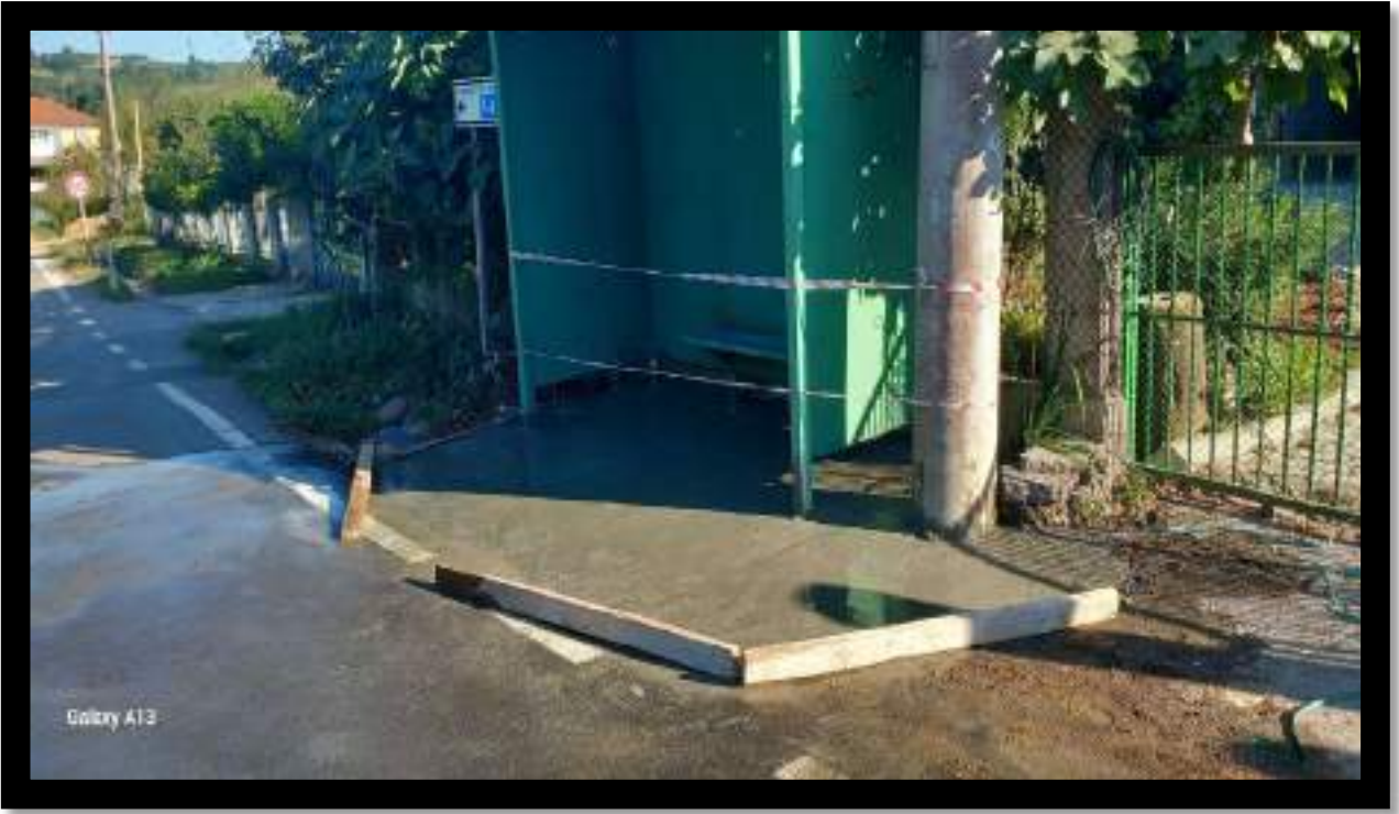
Safahı Mahallesi Durak Yeri Zemin Betonu Atma Çalışması
