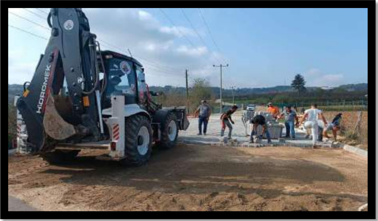
Dalca Mahallesi Parke İmalat Çalışması
