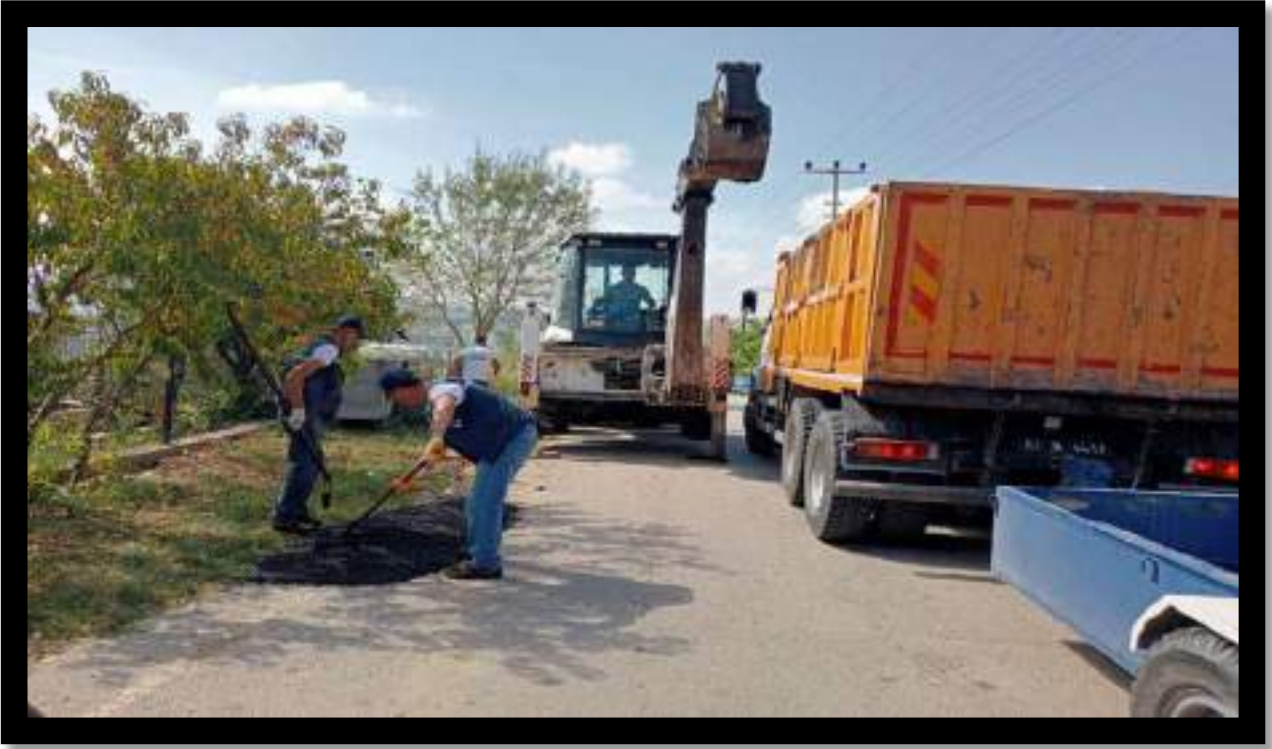
Hacıseyh Mahallesi Asfalt Bakım Onarım Çalışması
