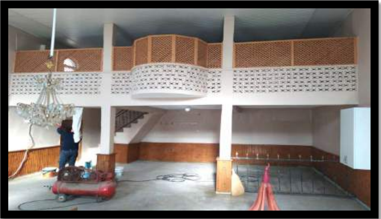
Eğercili Mahallesi Mollahasanlar Camii İç Cephe Boyama Çalışması
