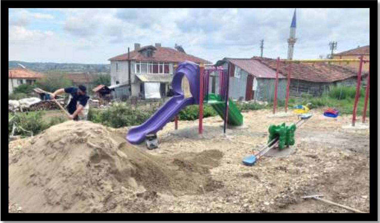
Özbey Mahallesi Oyun Grubu Montaj ve Kum Serim Çalışması
