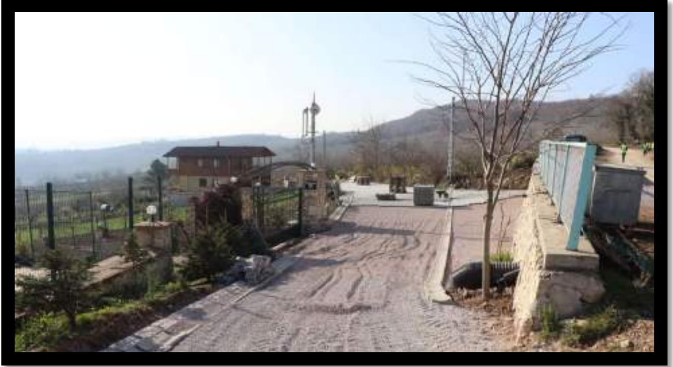
Hacımazlı Mahallesi Parke İmalat Çalışması
