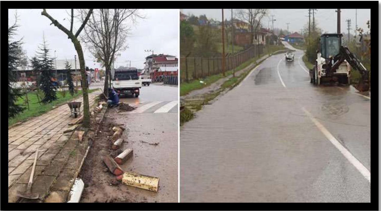
İlçe Genelinde Afetle Mücadele Çalışmaları
