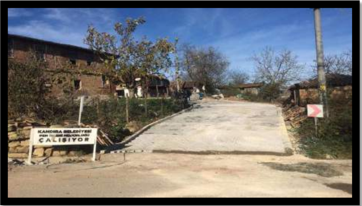
Sinanlı Bilalli Mahallesi Parke İmalat Çalışması
