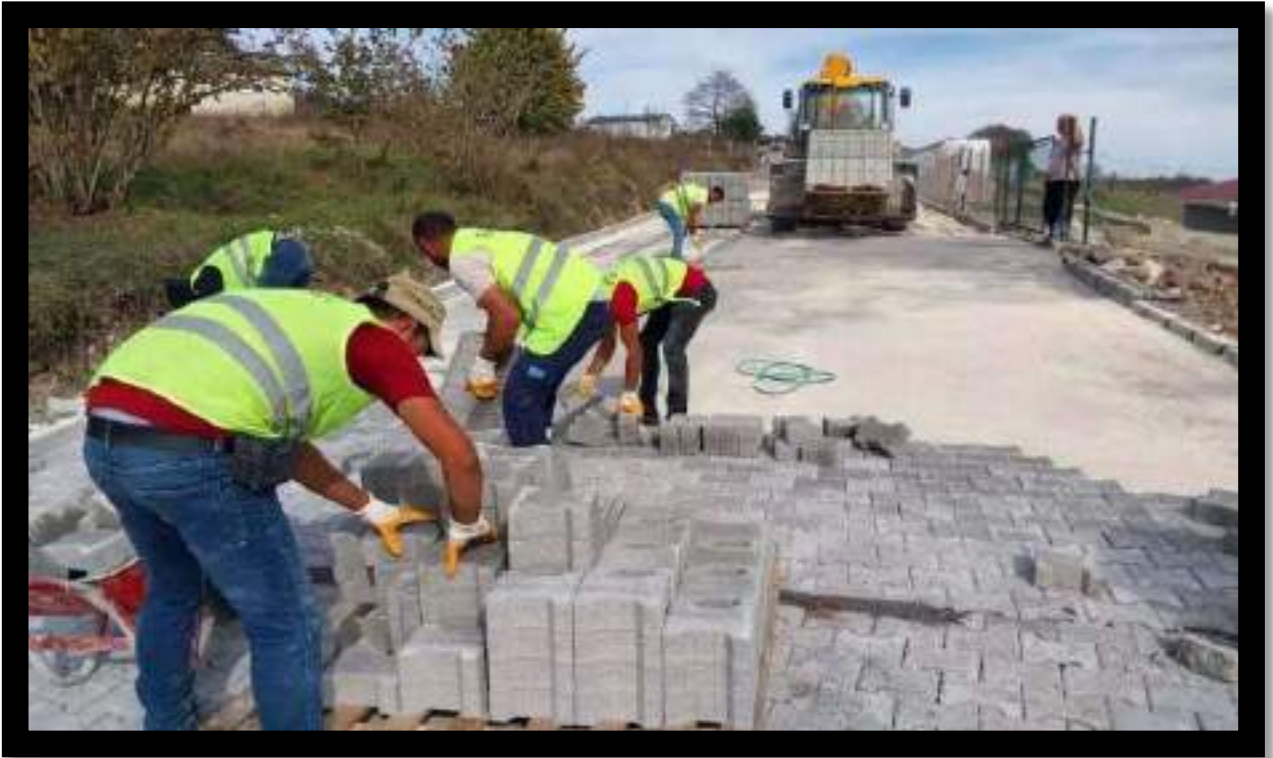
Kefken Mahallesi Parke İmalat Çalışması
