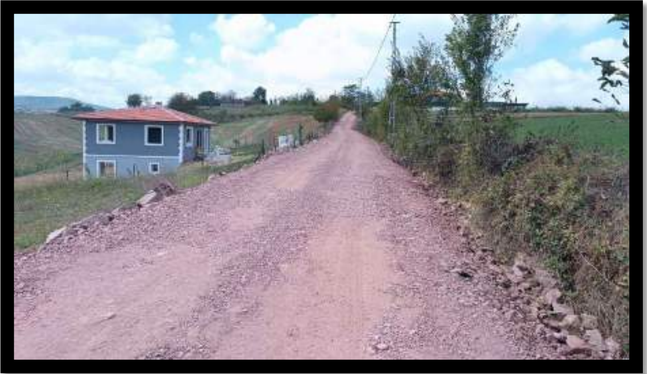
Sarıcaali Mahallesi Malzeme Serim Çalışması
