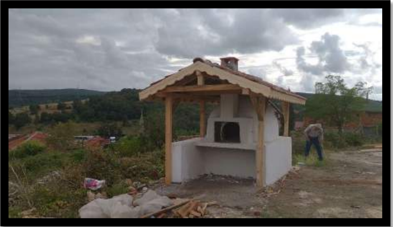
Çakmaklar Mahallesi Fırın İmalat Çalışması
