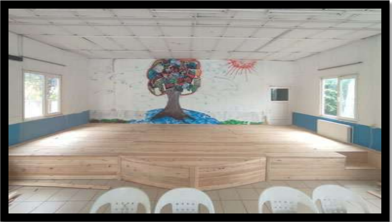
Bozburun Mahallesi Bozburun Okulu Sahne İmalat Çalışması
