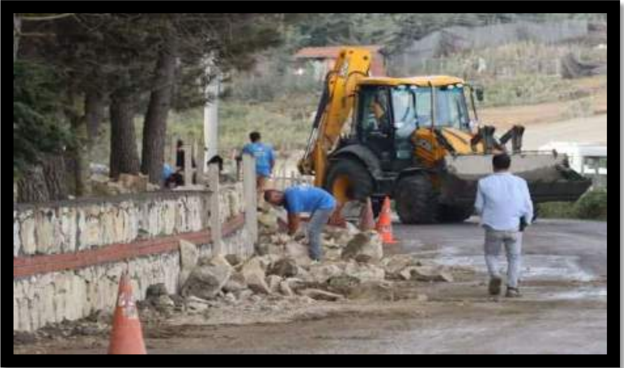
Bağrganlı Mahallesi Mezarlık Taş Duvar İmalat Çalışması
